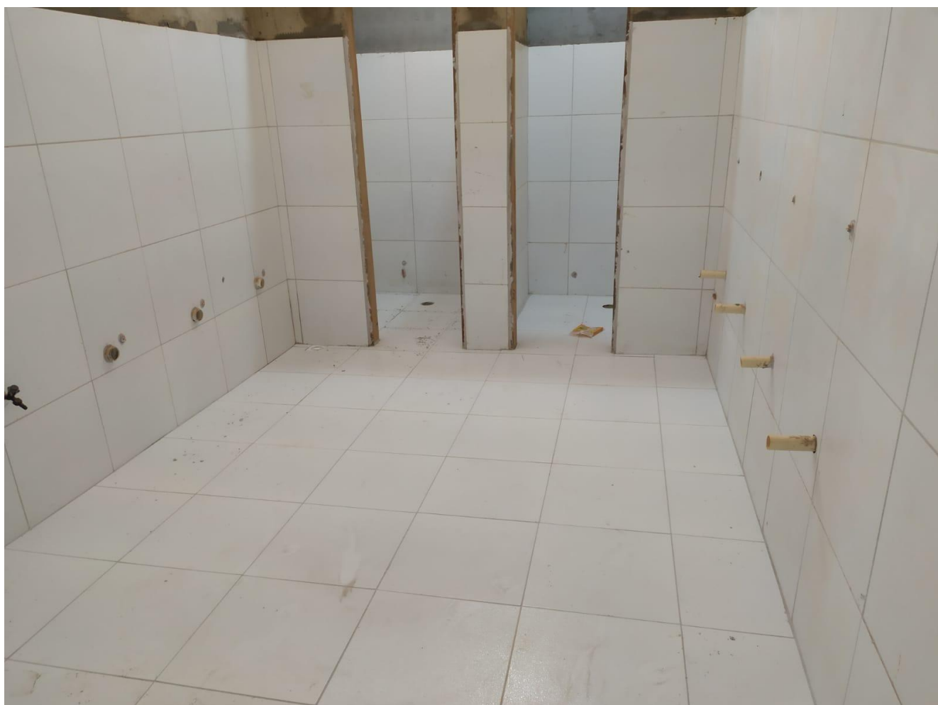
Foto 06 – Vista interna de um dos vestiários.
