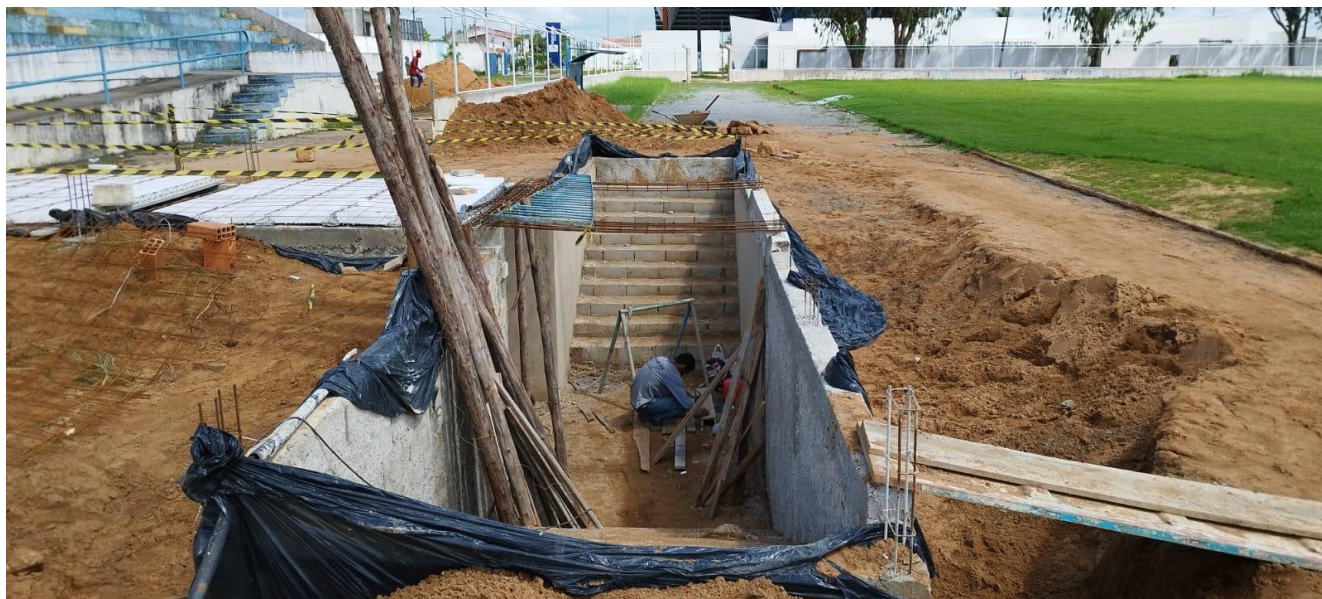
Foto 05 – Vista da construção do túnel de acesso dos atletas ao gramado.
