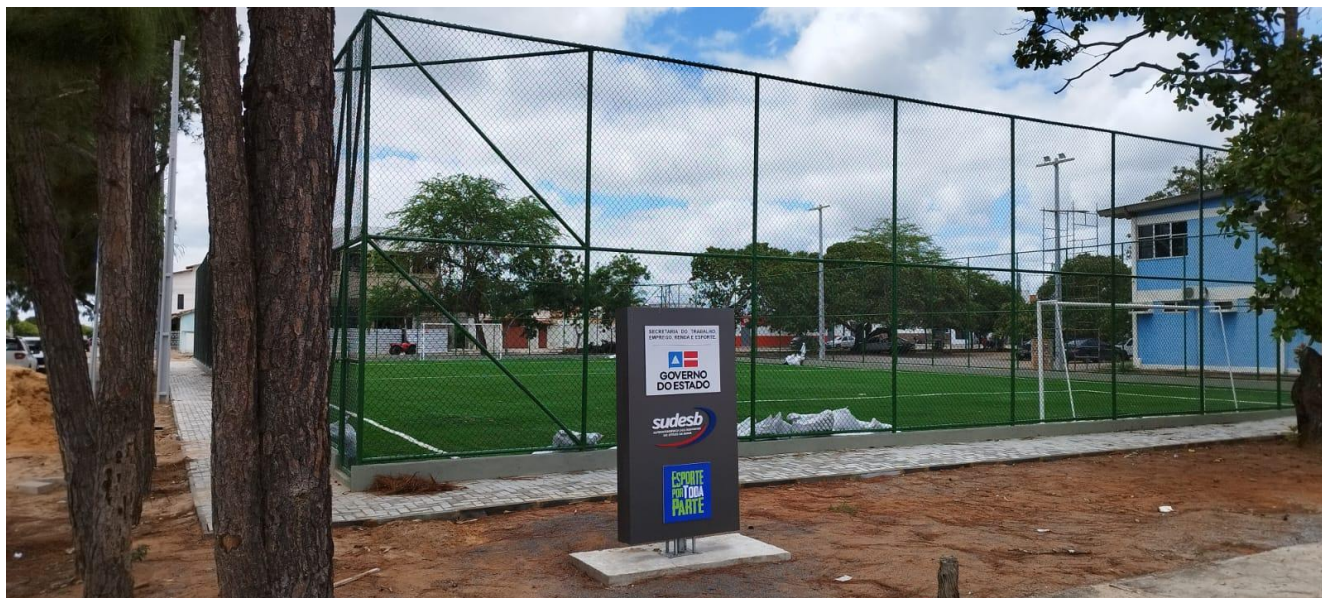
Foto 01 – Vista Geral da Areninha, Totem, Passeios, Alambrados, Gramado com demarcação e traves.
