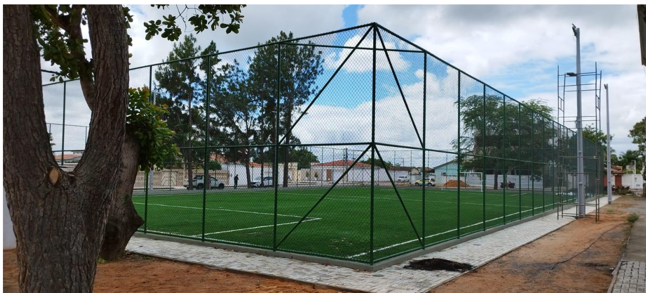
Foto 02 – Vista do serviço de iluminação em fase conclusiva.
