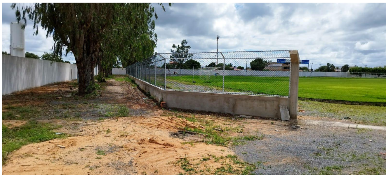
Foto 04 – Vista do muro divisório e do alambrado em volta do campo.
