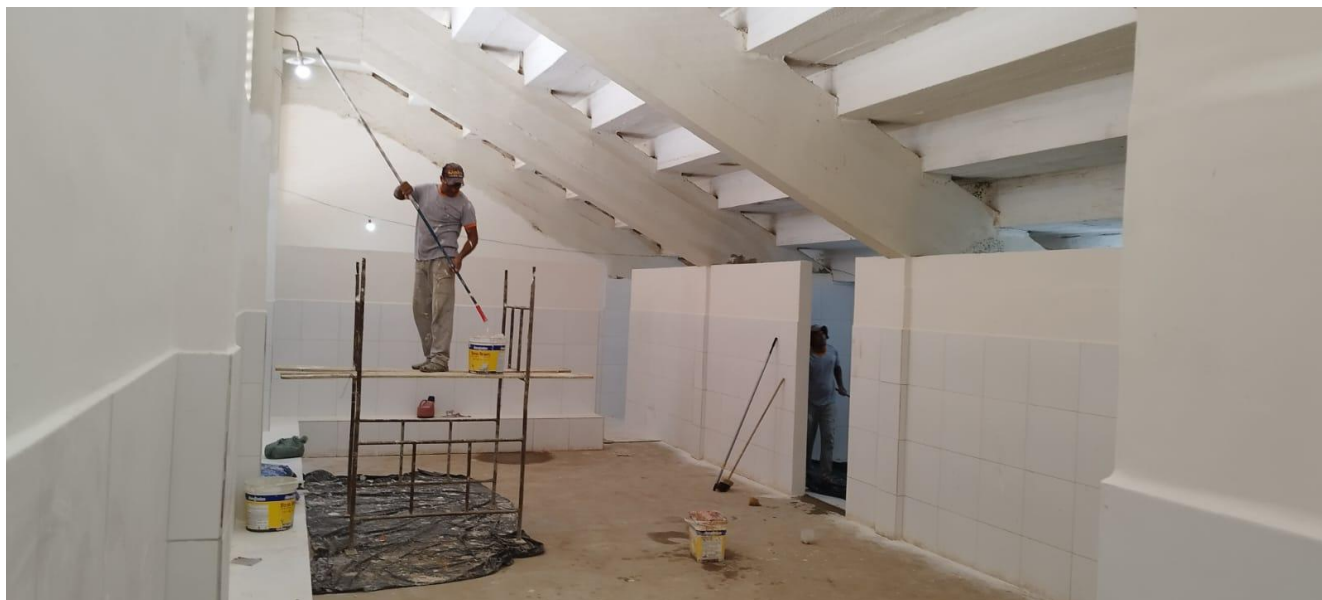
Foto 03 – Vista da recuperação da estrutura da arquibancada e pintura dos acessos ao vestiário.
