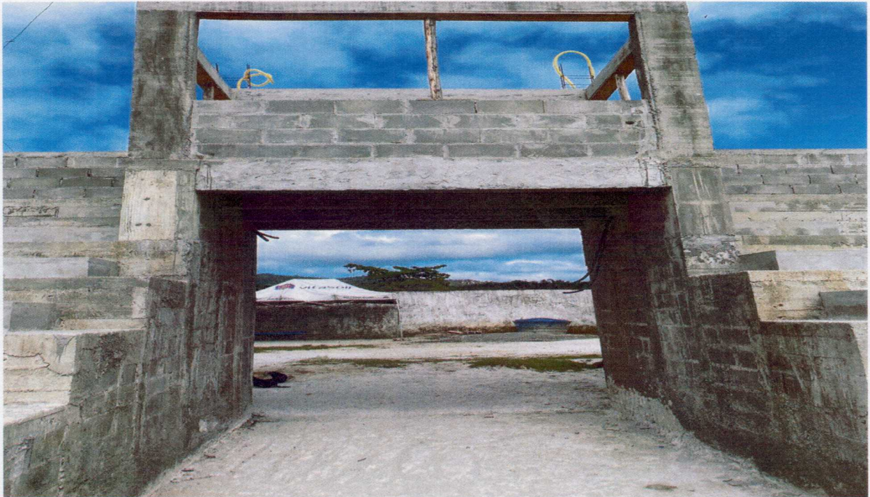
Foto 03 – PASSAGEM ENTRE ARQUIBANCADA.
