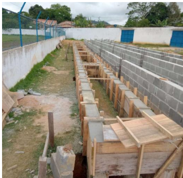
Foto 03 – ALVENARIA DA ARQUIBANCADA
