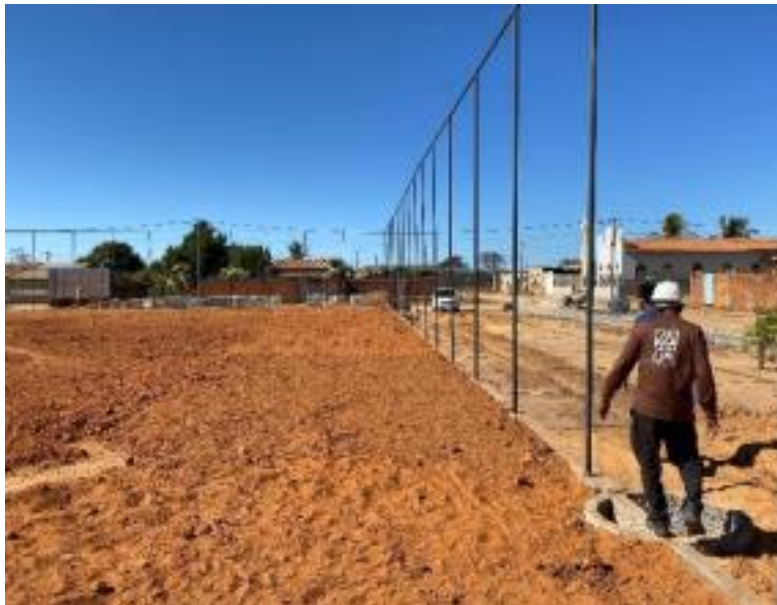
Foto 02 – Instalação do alambrado e escavação para sistema de iluminação.
