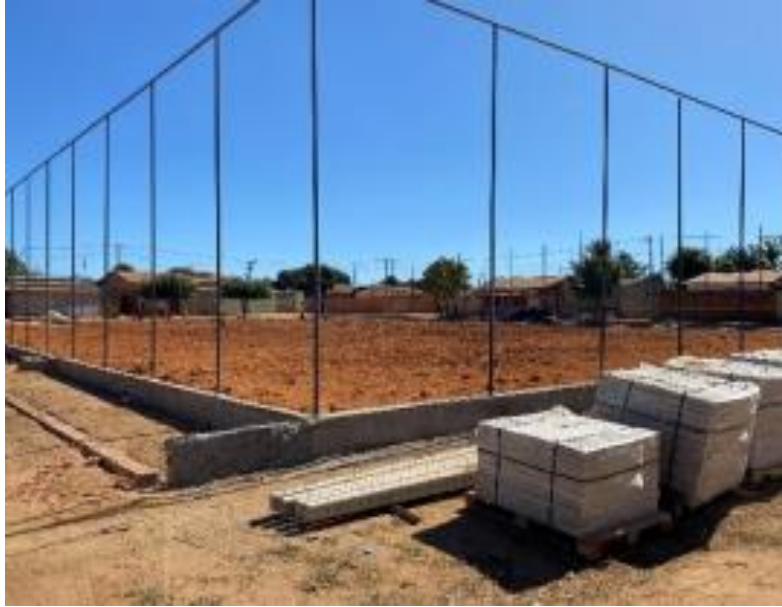
Foto 01 – Instalação do alambrado.
