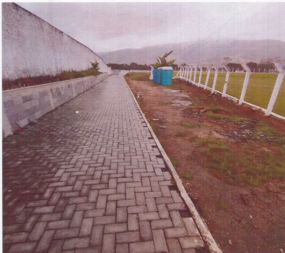
FOTO 02 – Execução de Piso Intertravado nos acessos principais (pendente arremates e pintura de guia)
