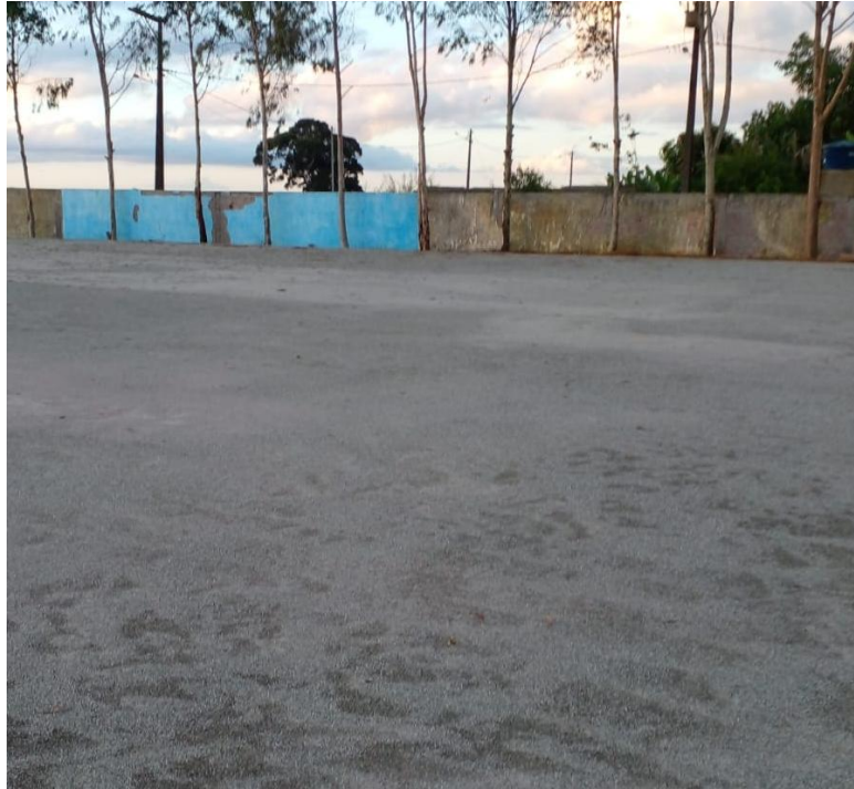
Foto 02 – MURETA DO ALAMBRADO.
