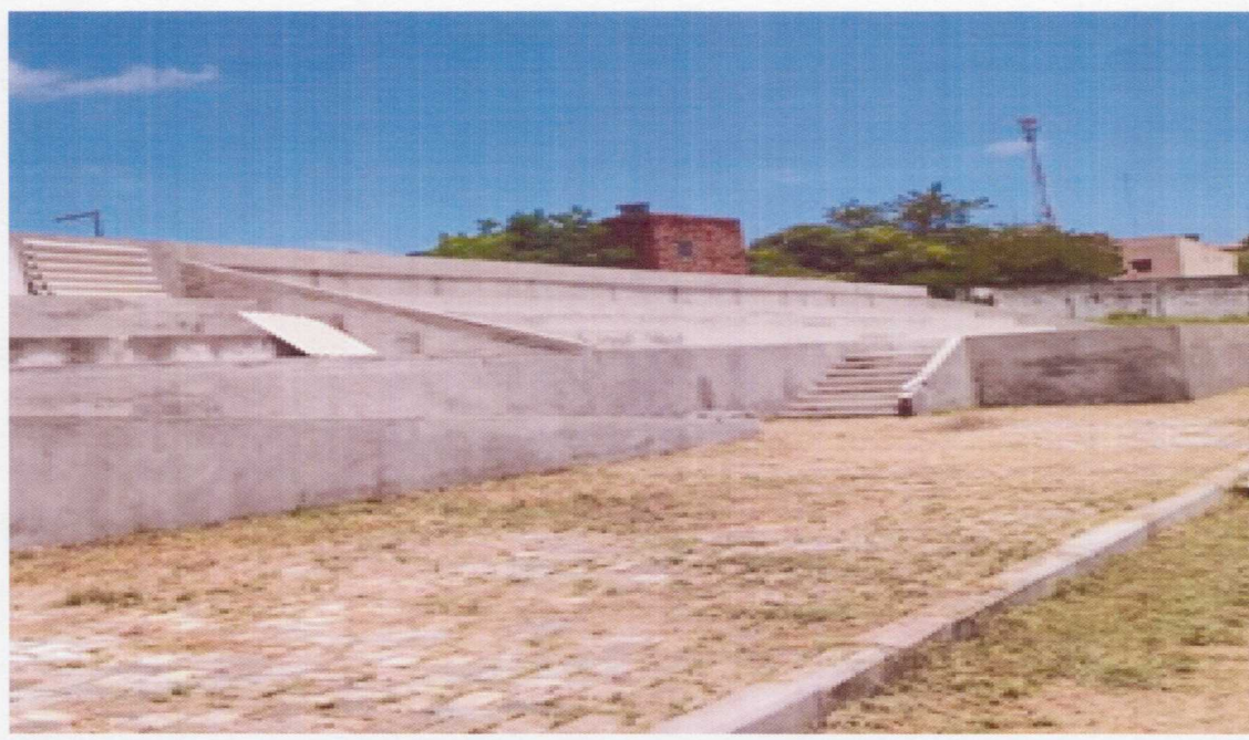
Foto 04 – Execução da arquibancada com cinco degraus.
