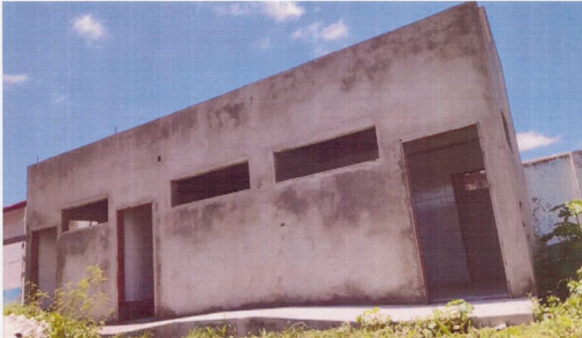
Foto 01 – Execução do Vestiário tipo C4.
