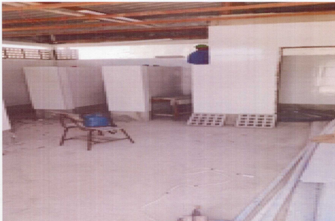
FOTO 03 – AREA INTERNA DO Sanitário.
