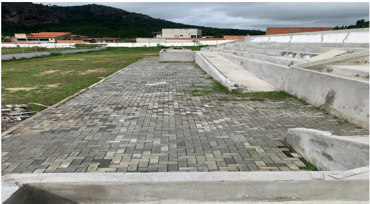
Foto 03 – Execução da arquibancada.
