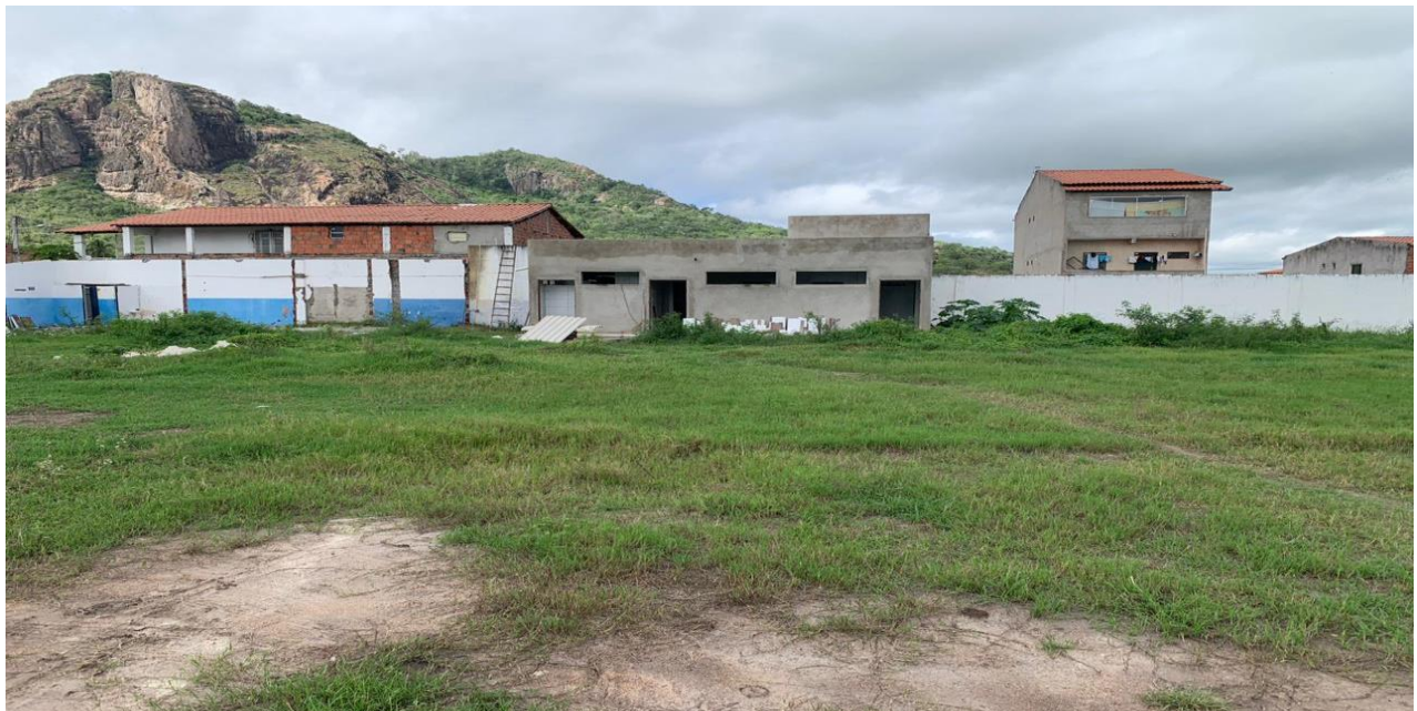
Foto 02 – Execução do Sanitário Público.
