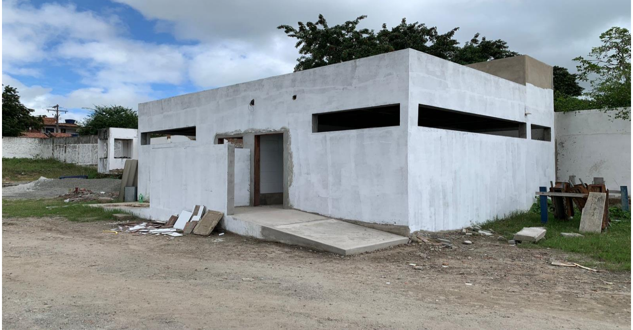
Foto 01 – Execução do Vestiário C4.
