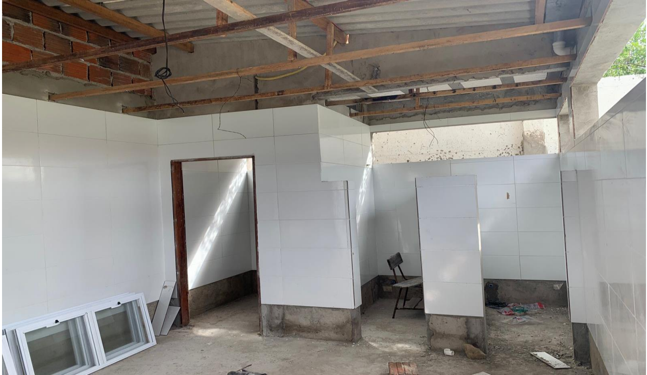
FOTO 03 – AREA INTERNA DO VESTIARIO.
