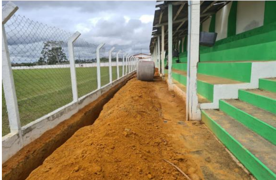
Foto 02 – Instalação de poste.
