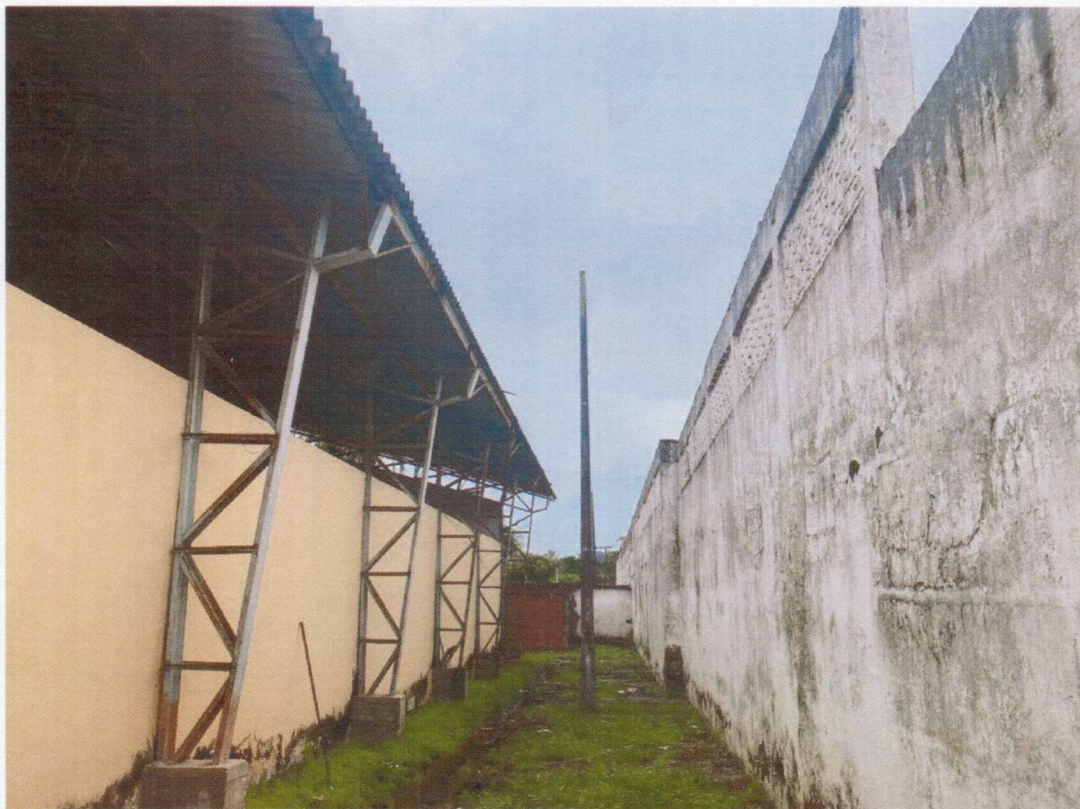
FOTO 02 – Poste antigo 02, ainda não trocado.
