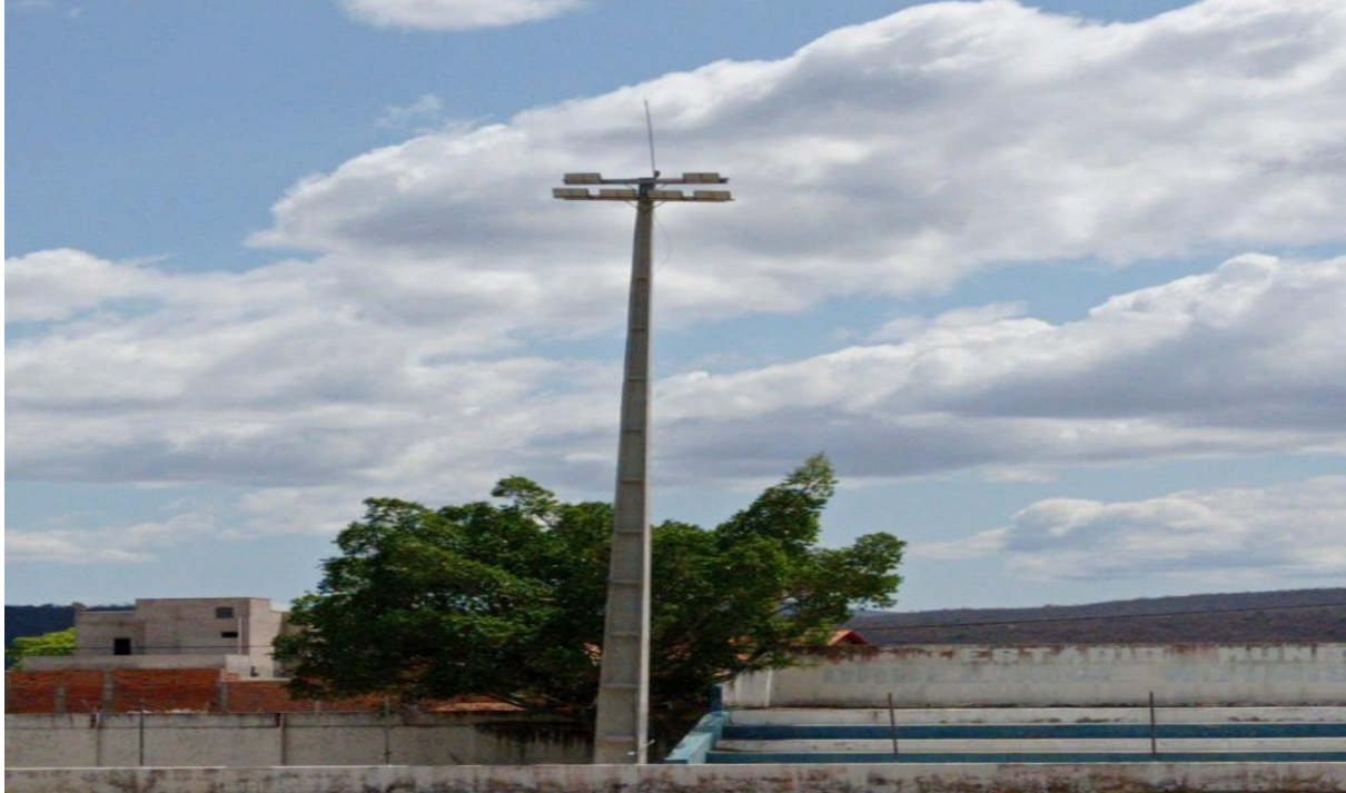
Foto 01 – Instalação do poste com refletores.
