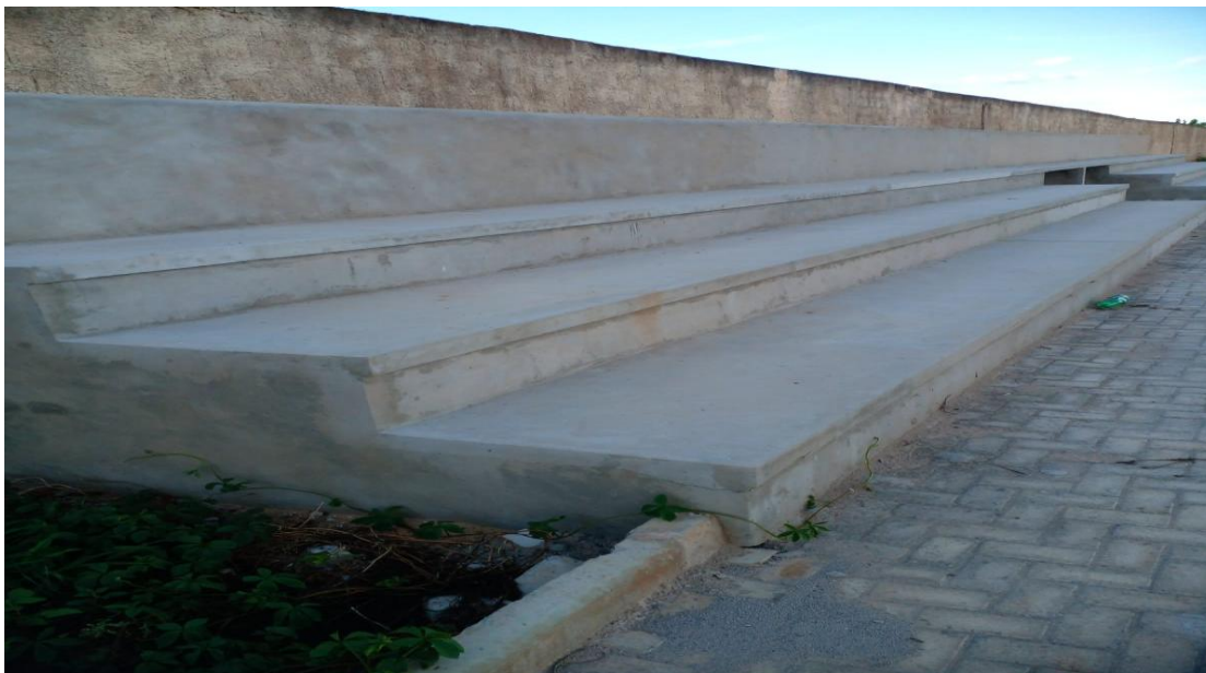
Foto 04 – Execução da arquibancada 30 metros com 03 degraus.
