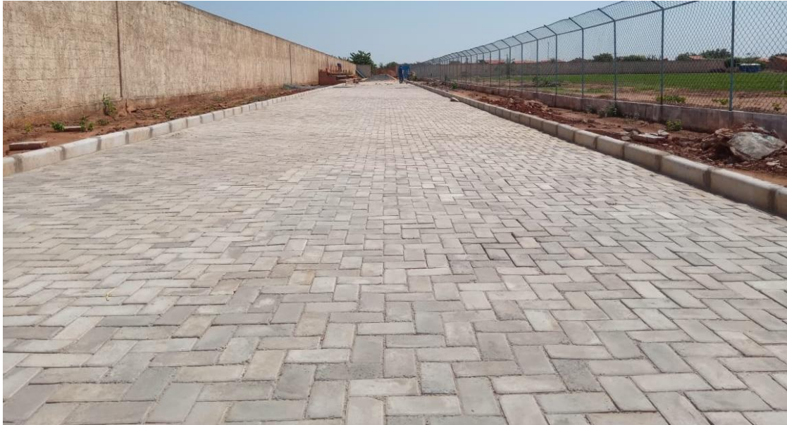
Foto 05 – Execução da pavimentação.
