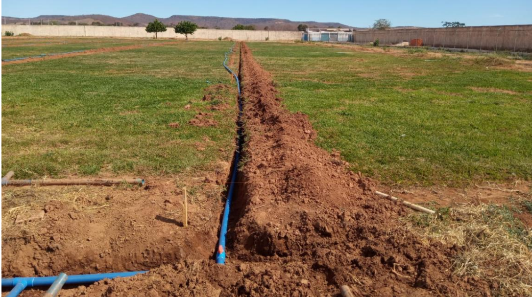
Foto 01 – Implantação do Sistema de Irrigação.
