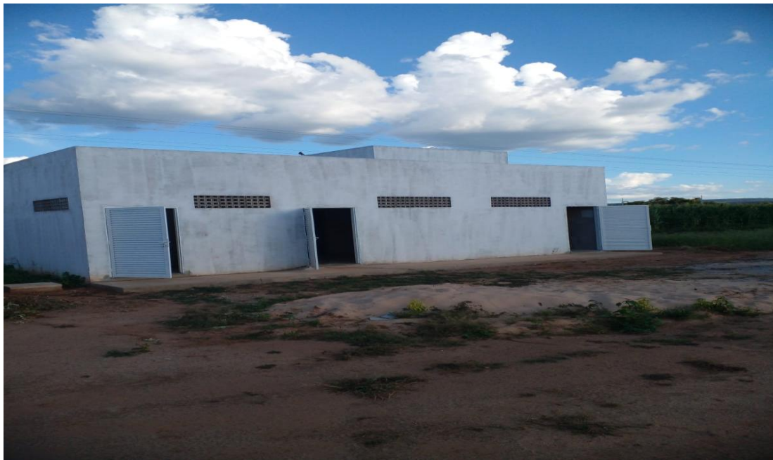
Foto 02 – Construção do vestiário tipo C4.
