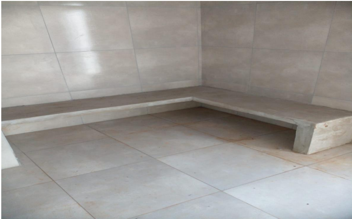
Foto 03 – Vista interna do Vestiário C4.
