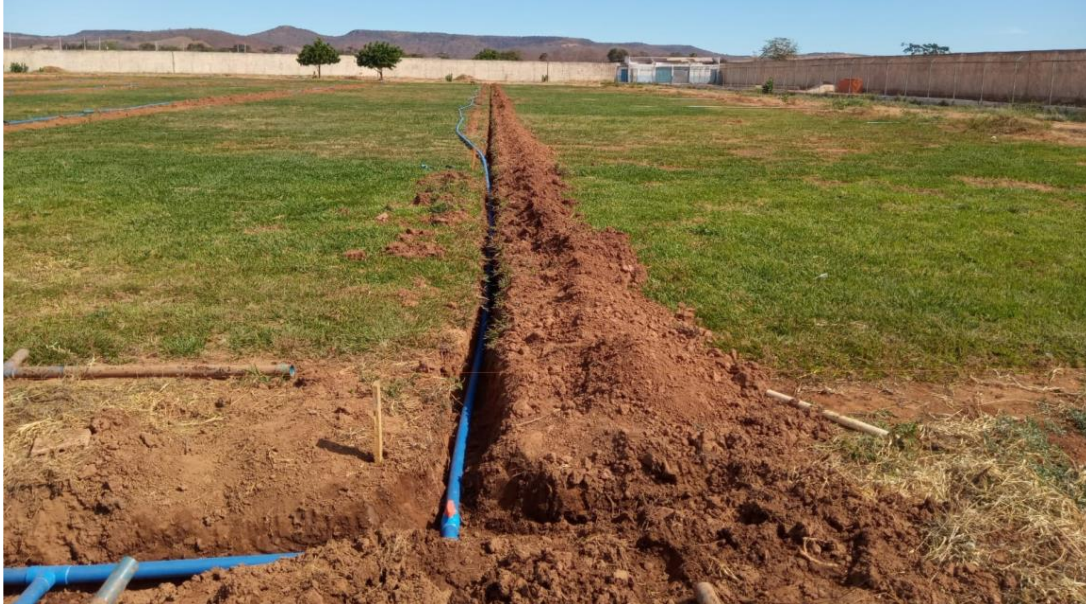
Foto 01 – Implantação do Sistema de Irrigação.
