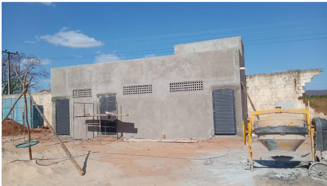
Foto 02 – Construção do vestiário tipo C4.
