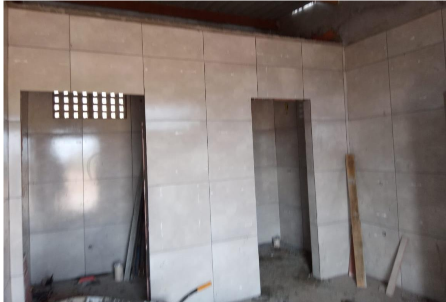
Foto 04 – Execução da arquibancada 30 metros com 03 degraus.
