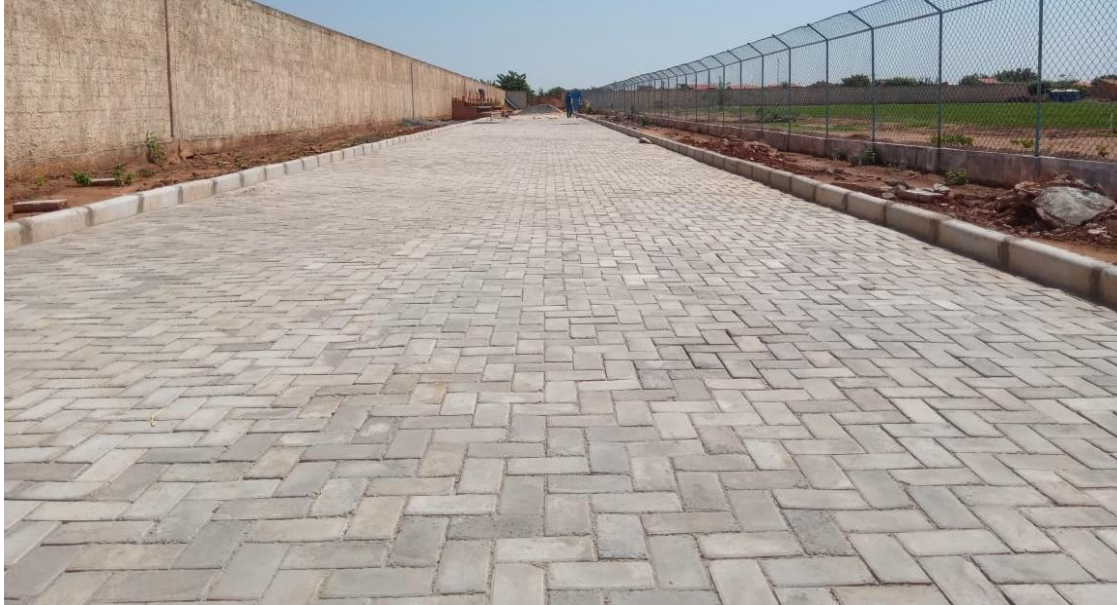
Foto 05 – Execução da pavimentação.
