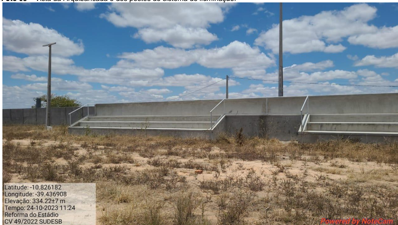
Foto 03 – Vista da Arquibancada e dos postes do sistema de iluminação.
