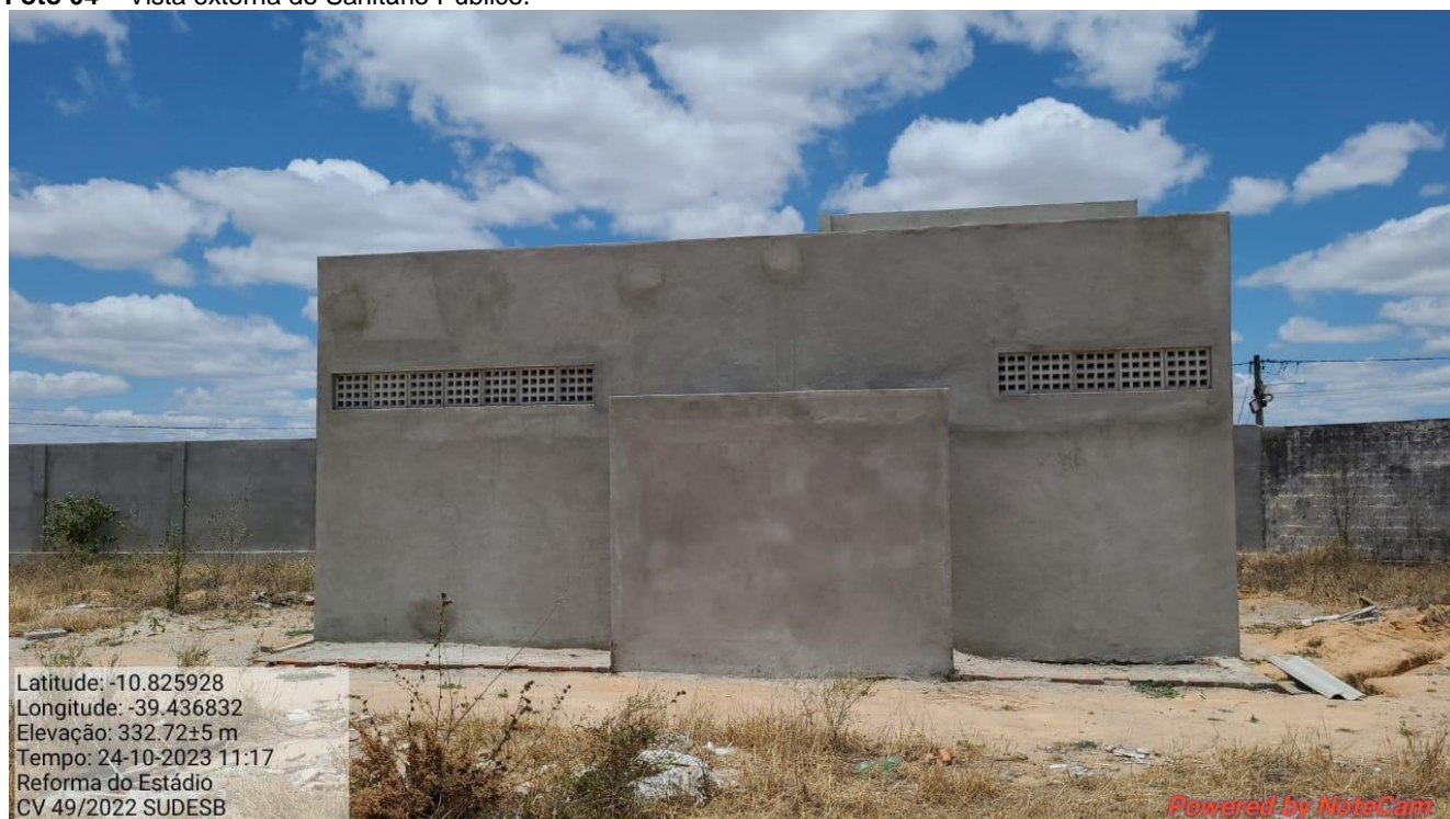
Foto 04 – Vista externa do Sanitário Público.
