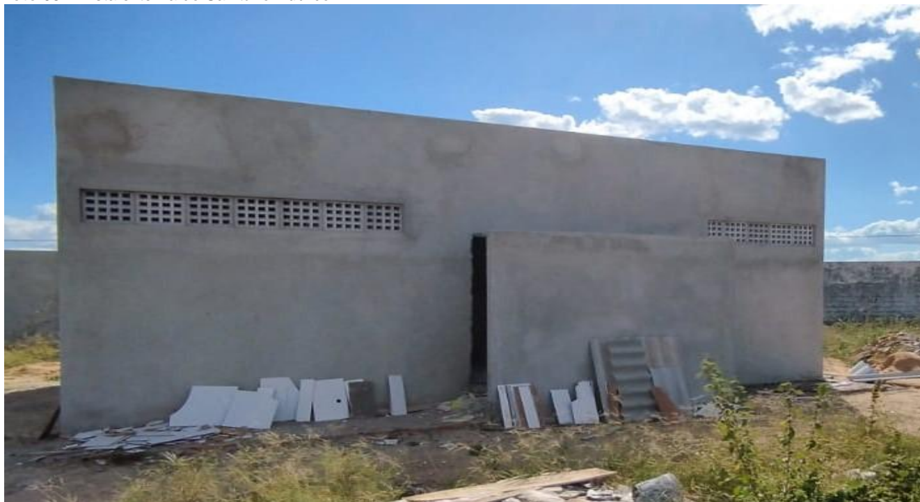
Foto 03 – Vista externa do Sanitário Público.
