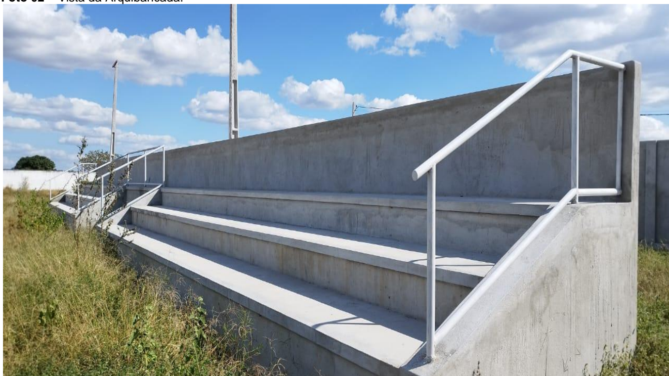
Foto 02 – Vista da Arquibancada.
