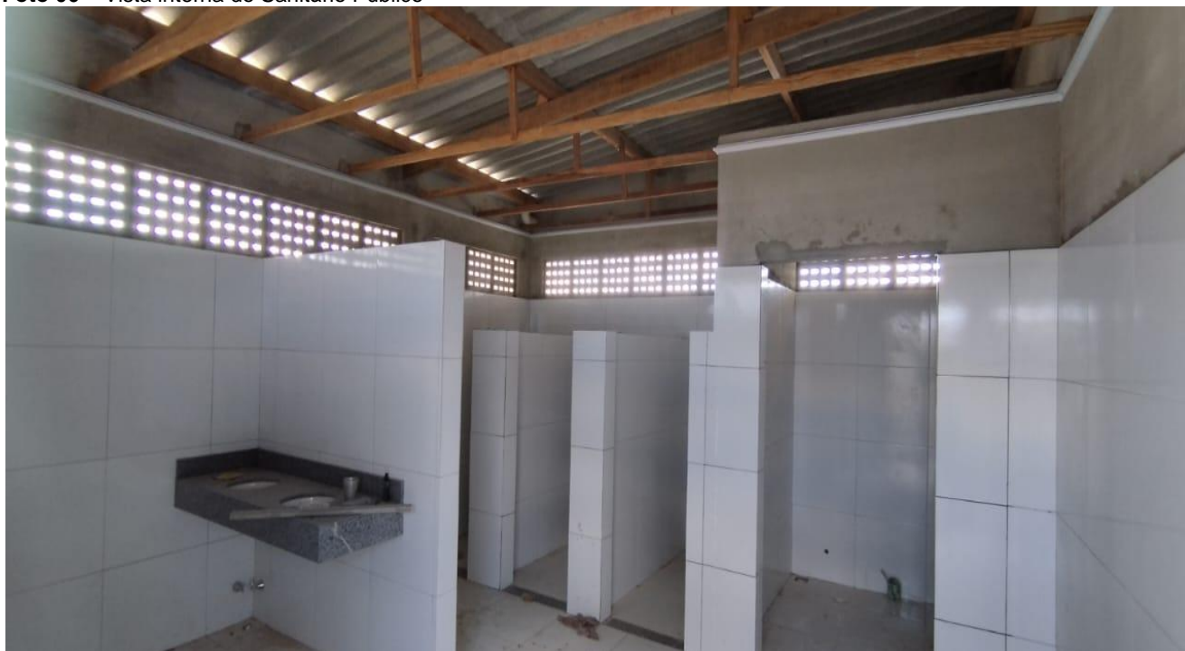
Foto 06 – Vista interna do Sanitário Público
