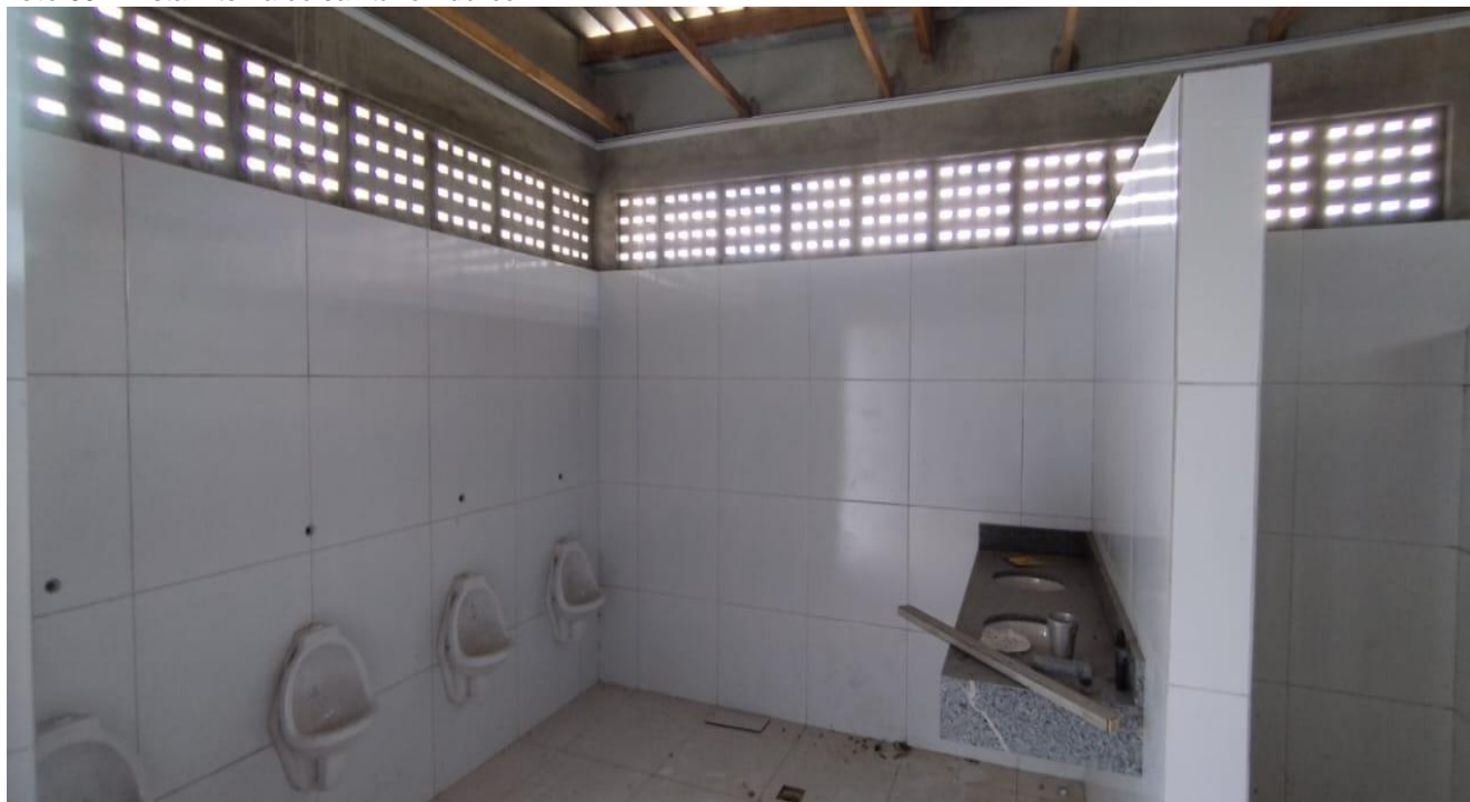
Foto 05 – Vista Interna do sanitário Público.
