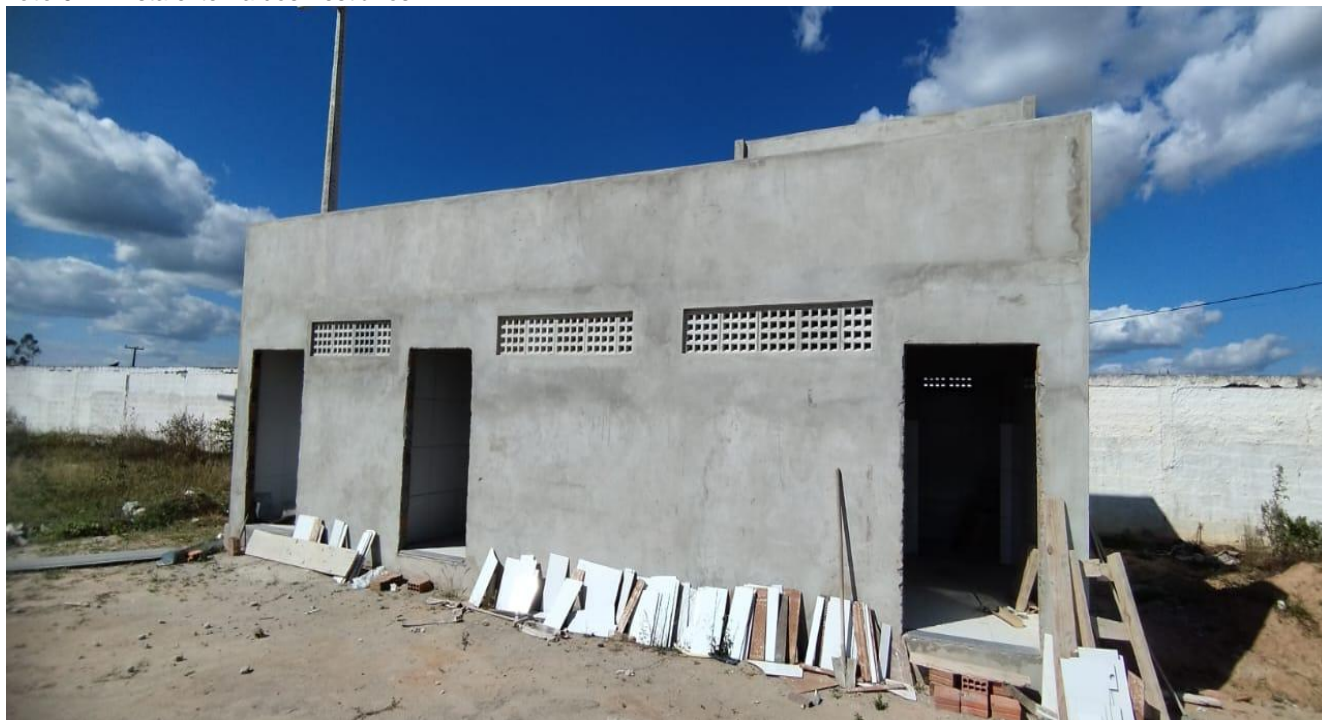
Foto 04 – Vista externa dos Vestiários.
