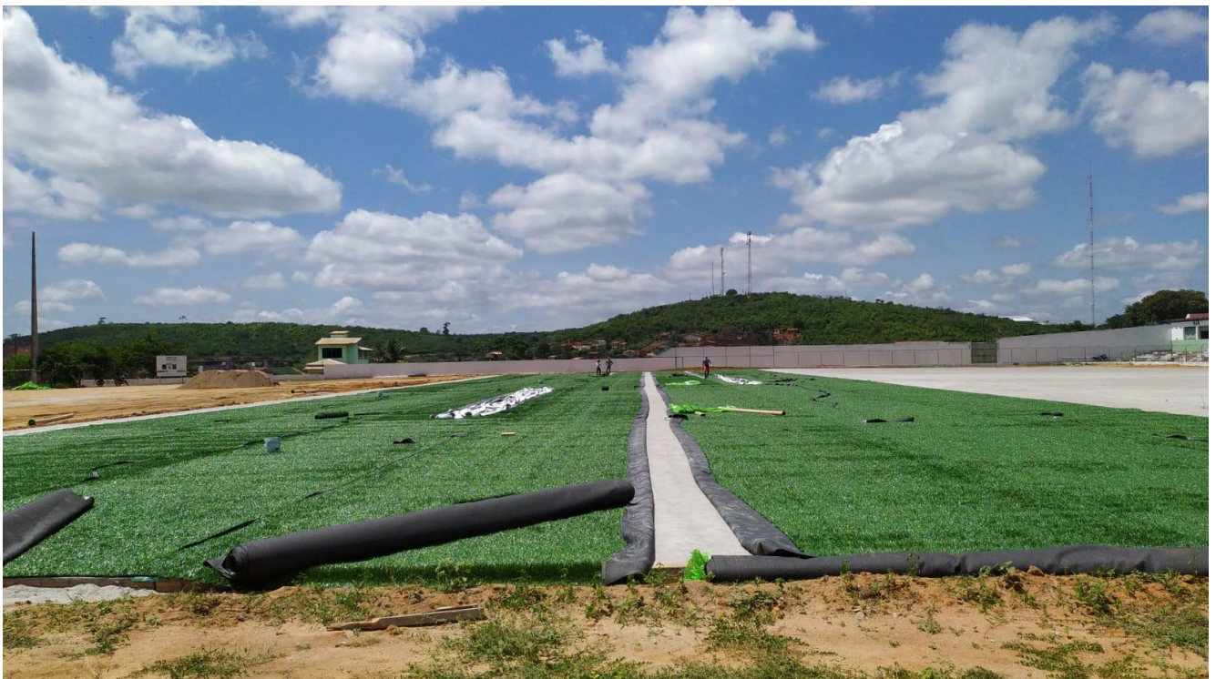
Foto 02 – Instalação da grama sintética
