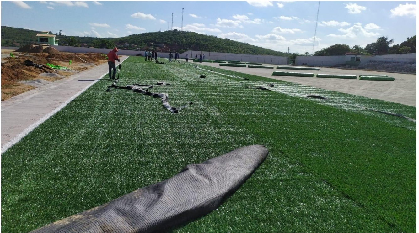
Foto 02 – Instalação da grama sintética
