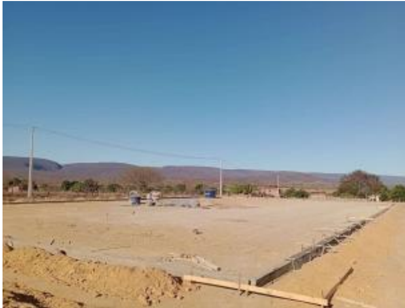
Foto 02 – Nivelamento com o brita para execução de grama sintética.
