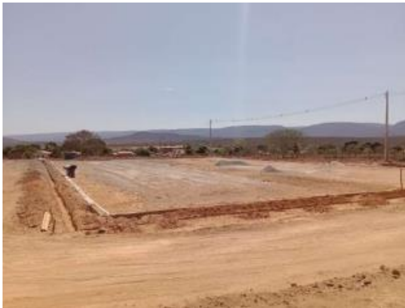
Foto 02 – Nivelamento com o brita para execução de grama sintética.
