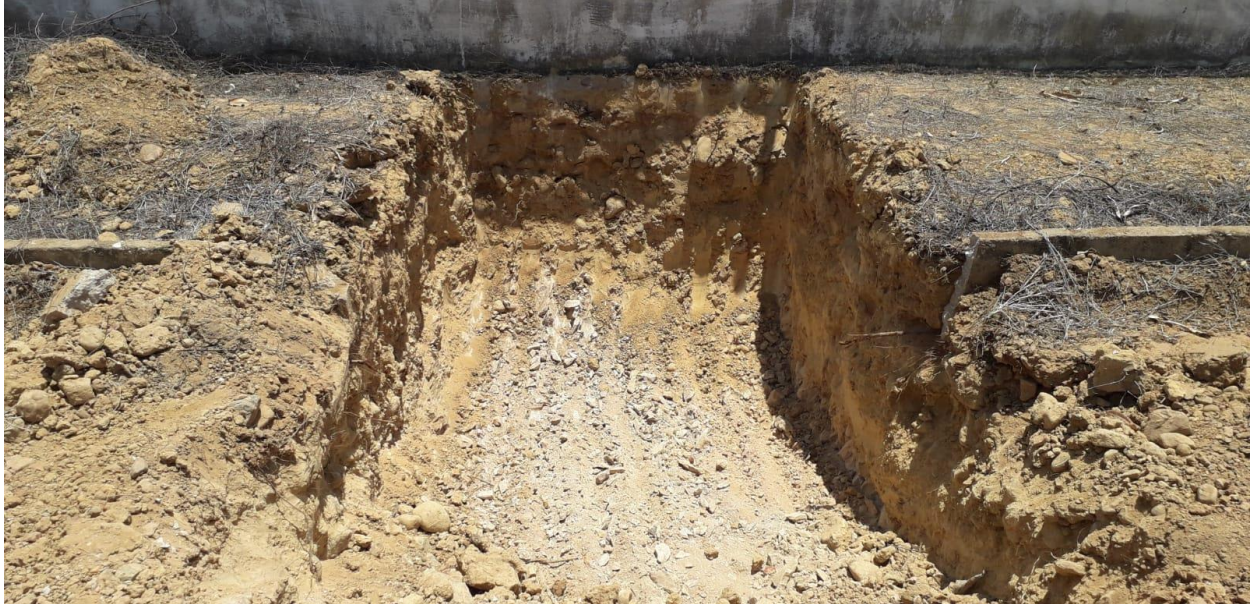
Foto 01 – Escavação de vala para implantação do sistema de iluminação.
