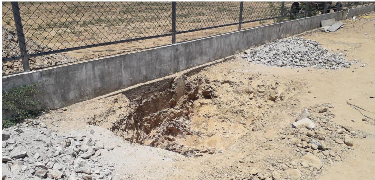
Foto 02 – Escavação de vala para implantação do sistema de iluminação.
