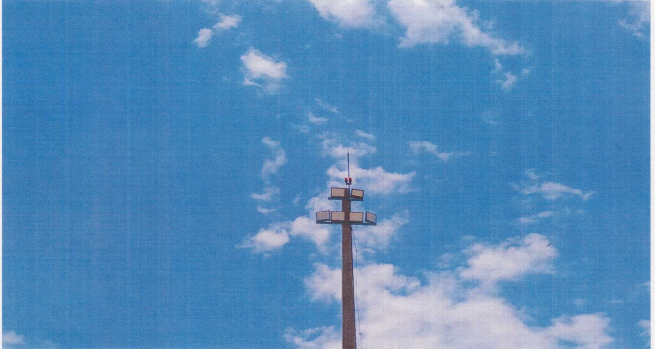
FOTO 05 – Vista da torre de Iluminação.
