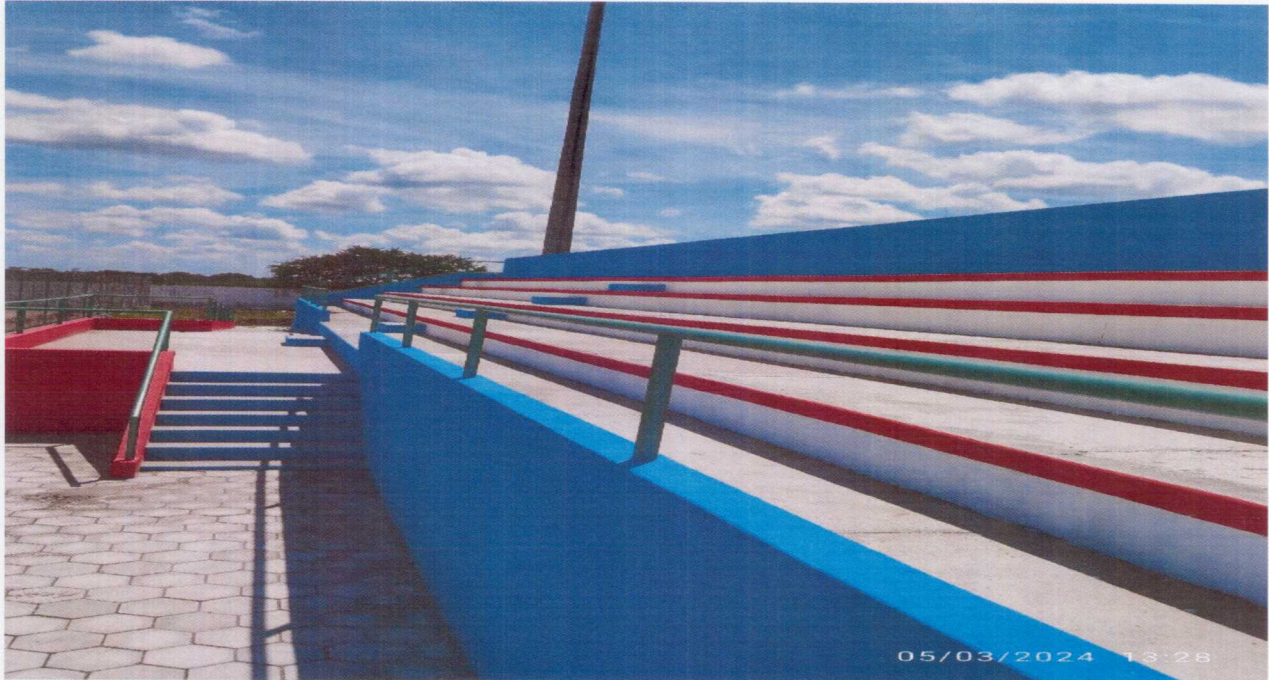
FOTO 03 – Vista da Arquibancada.
