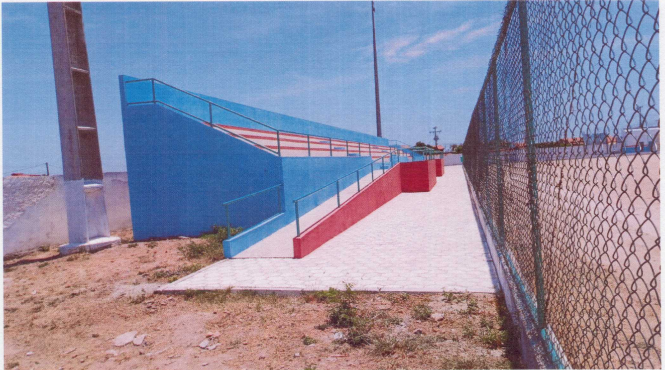
FOTO 03 – Vista da Arquibancada.
