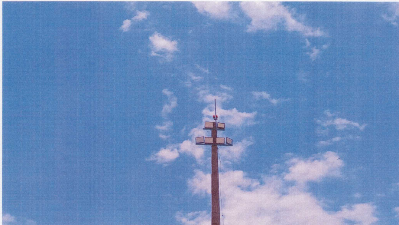
FOTO 05 – Vista detalhe da torre de iluminação.
