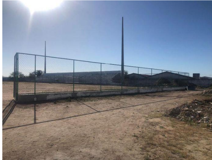
Foto 03 – REFORMA DO ALAMBRADO
