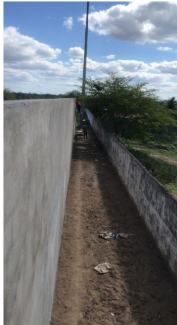
Foto 02 – CHAPISCO APLICADO EM ALVENARIAS E ESTRUTURAS DE CONCRETO INTERNAS.
