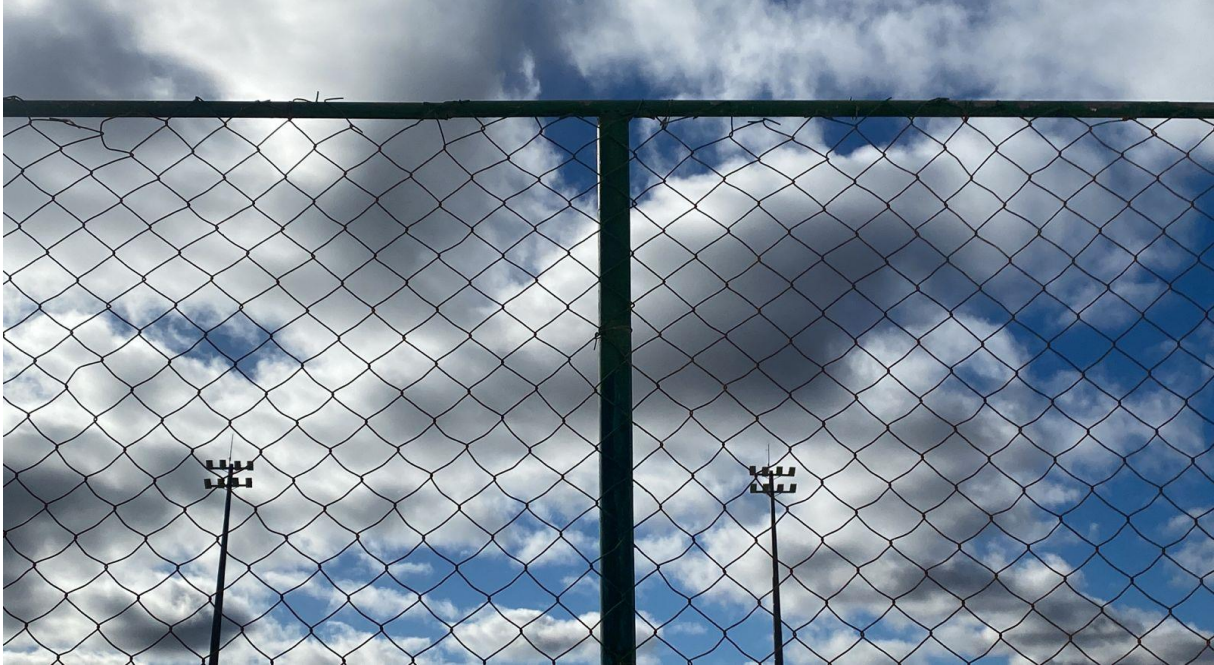
Foto 03 – Implantação do Sistema de Iluminação.
