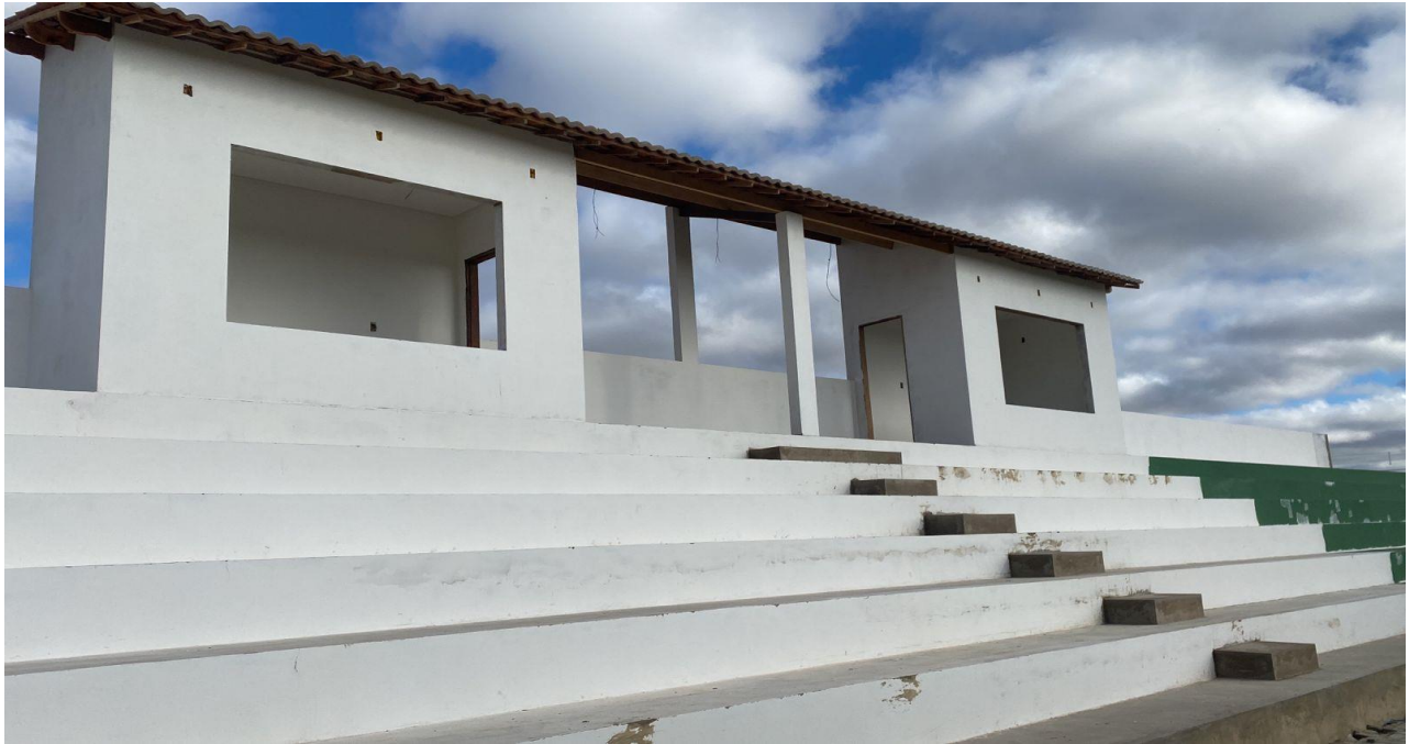
Foto 01 – Modulo de arquibancada com cabine.
