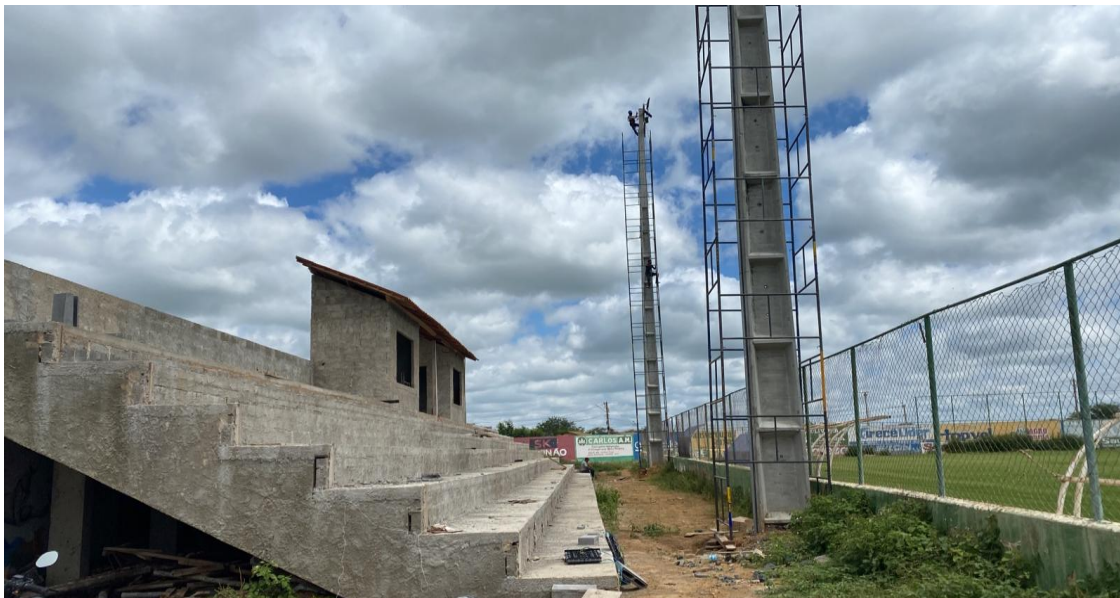
Foto 02 – Execução da arquibancada com cabine e implantação do Sistema de Iluminação.
