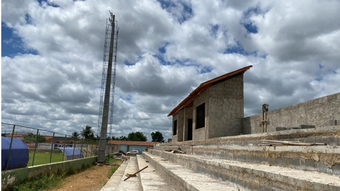
Foto 01 – Execução dos patamares da arquibancada e cabine.
