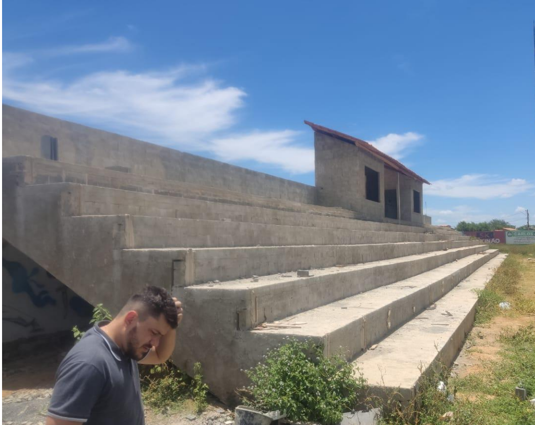
Foto 01 – Execução dos patamares da arquibancada e cabine.
