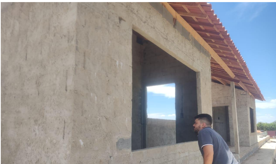
Foto 02 – Execução da arquibancada com cabine e implantação do Sistema de Iluminação.
