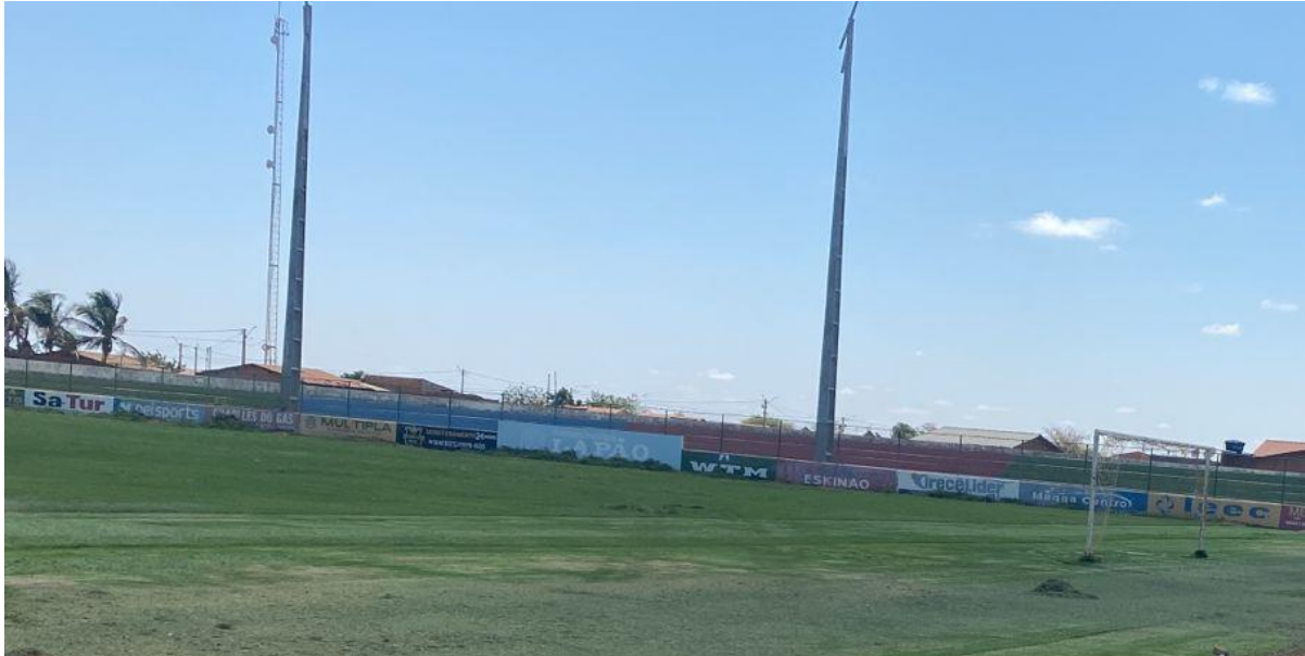
Foto 03 – Implantação do Sistema de Iluminação.
