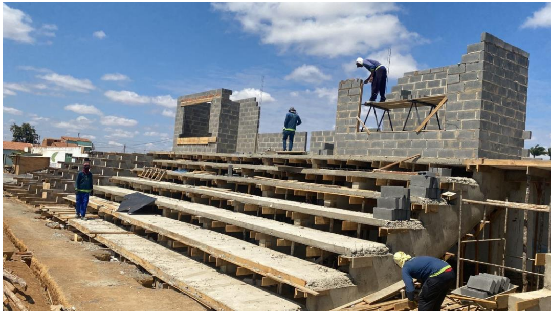
Foto 01 – Execução dos patamares da arquibancada e cabine.
