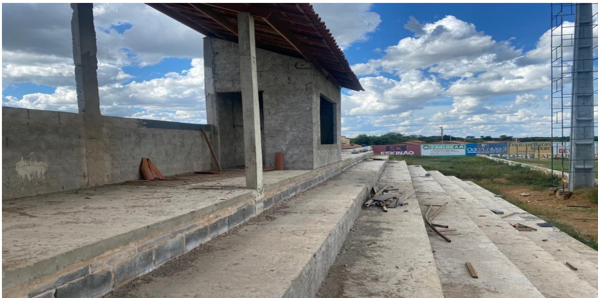
Foto 02 – Execução da arquibancada com cabine e implantação do Sistema de Iluminação.
