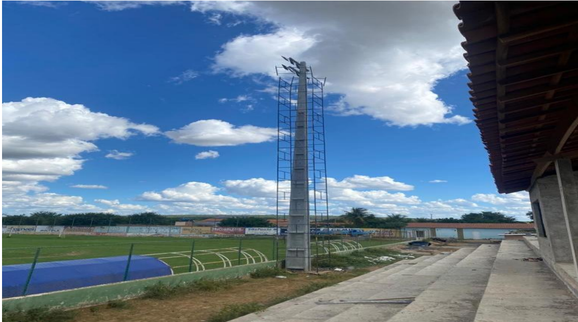
Foto 03 – Implantação do Sistema de Iluminação.
