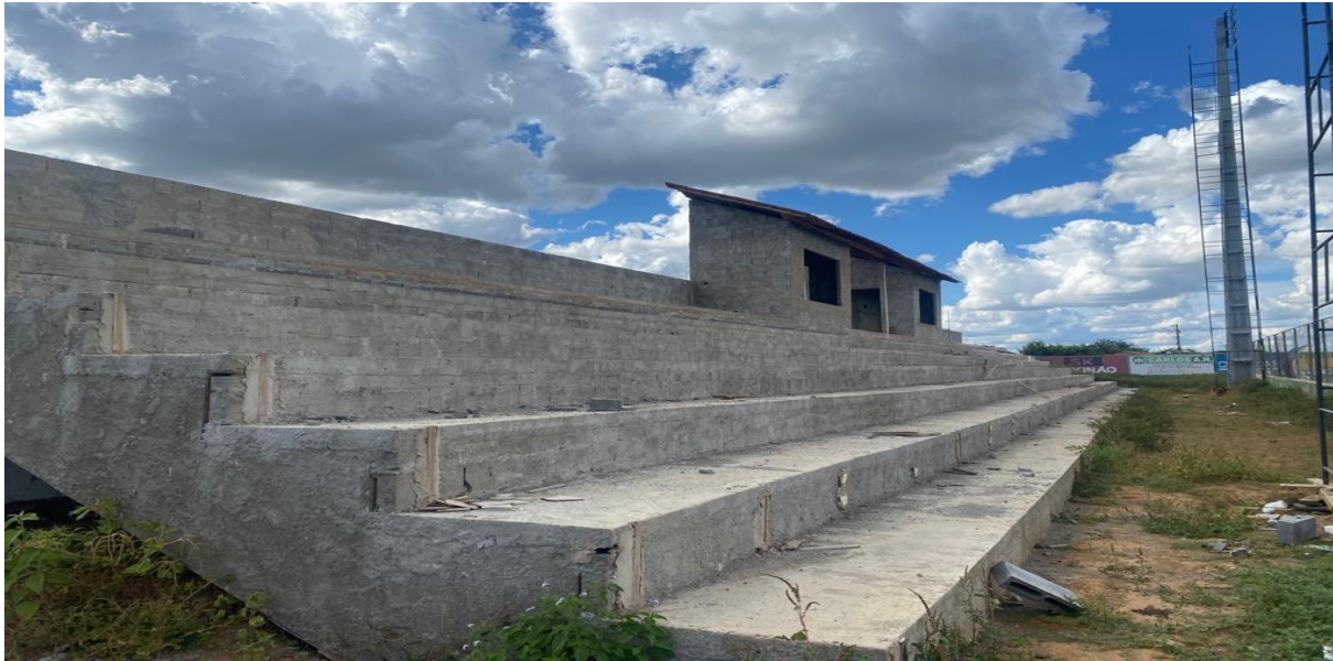
Foto 01 – Execução dos patamares da arquibancada e cabine.
