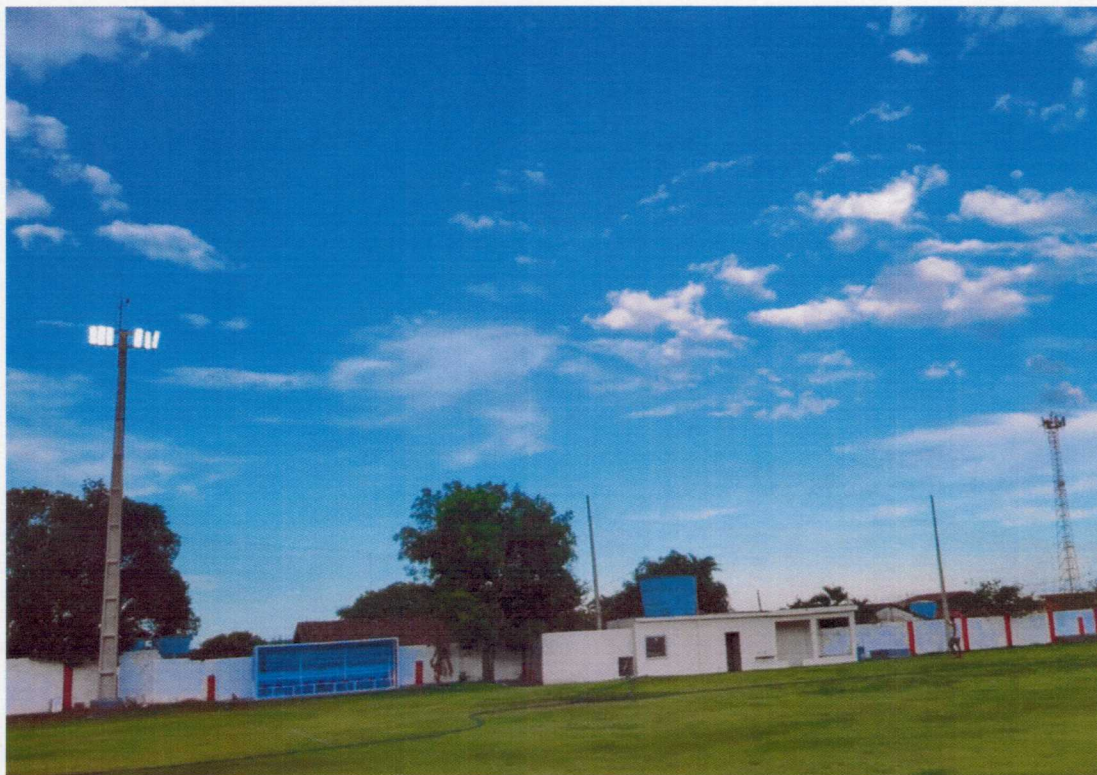
FOTO 03 – IMPLANTAÇÃO DO SISTEMA DE ILUMINAÇÃO
