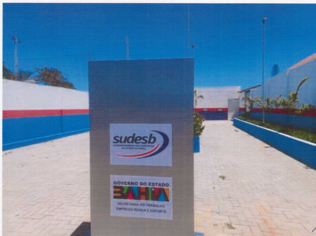
FOTO 6 – INSTALAÇÃO DO TOTEM INSTITUCIONAL EXTERNO.
