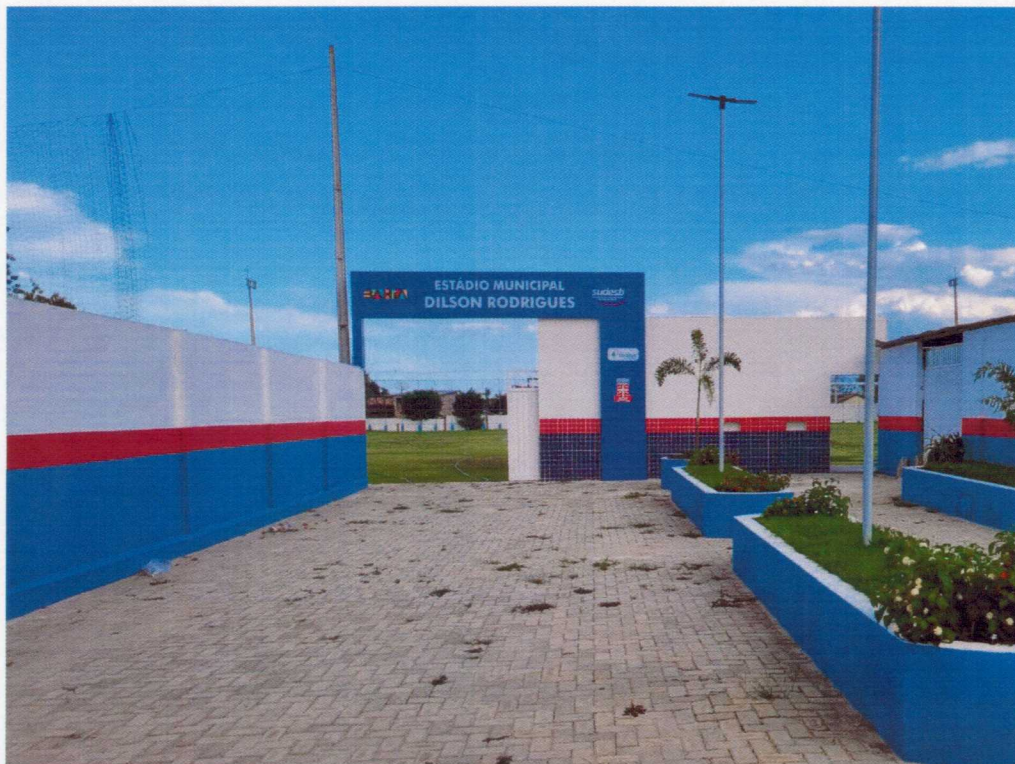
FOTO 05 – CONSTRUÇÃO DE PÓRTICO DE FACHADA EM ACM.
