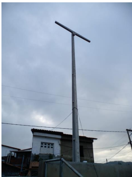
Foto 04 – Execução do sistema de iluminação.
