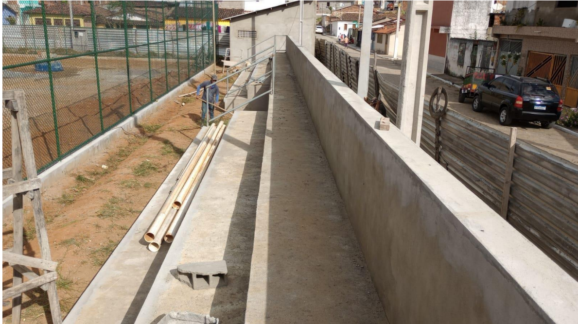
Foto 05 – Vista da execução do poste do sistema de Iluminação, Arquibancada e Alambrados.
