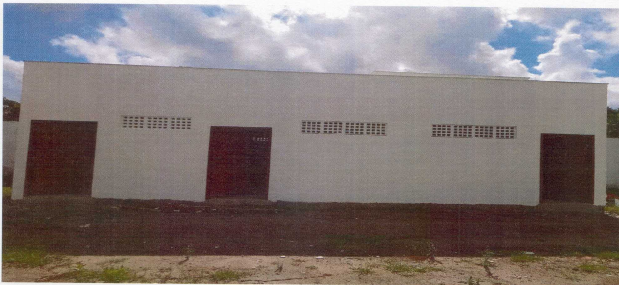
Foto 01 – Vista do vestiário.
