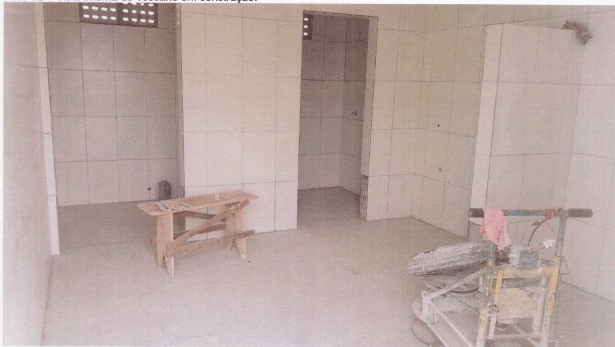
Foto 02 – Vista interna do vestiário em construção.
