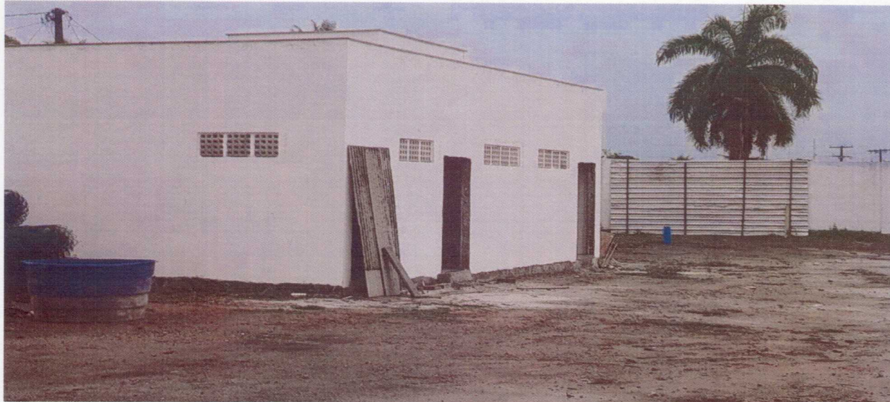
Foto 01 – Vista do vestiário.
