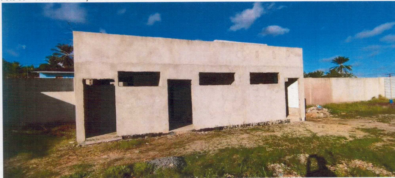
Foto 03 – Vista da construção dos Vestiários.
