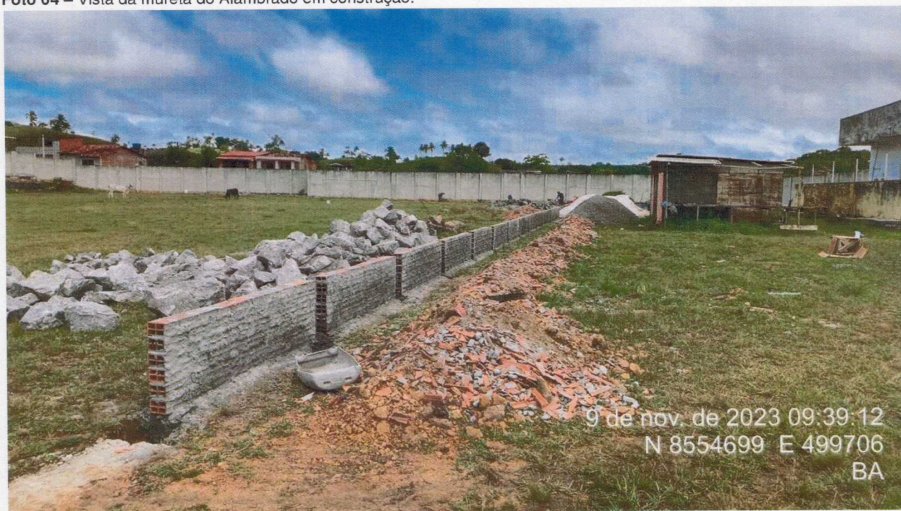
Foto 04 – Vista da mureta do Alambrado em construção.
