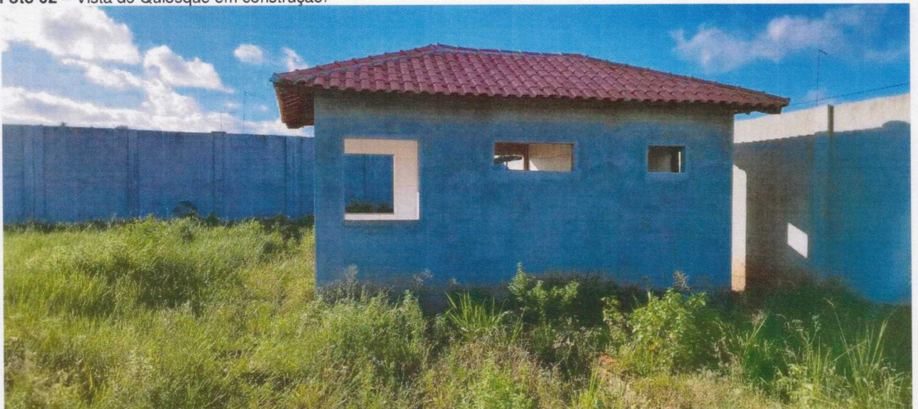
Foto 02 – Vista do Quiosque em construção.
