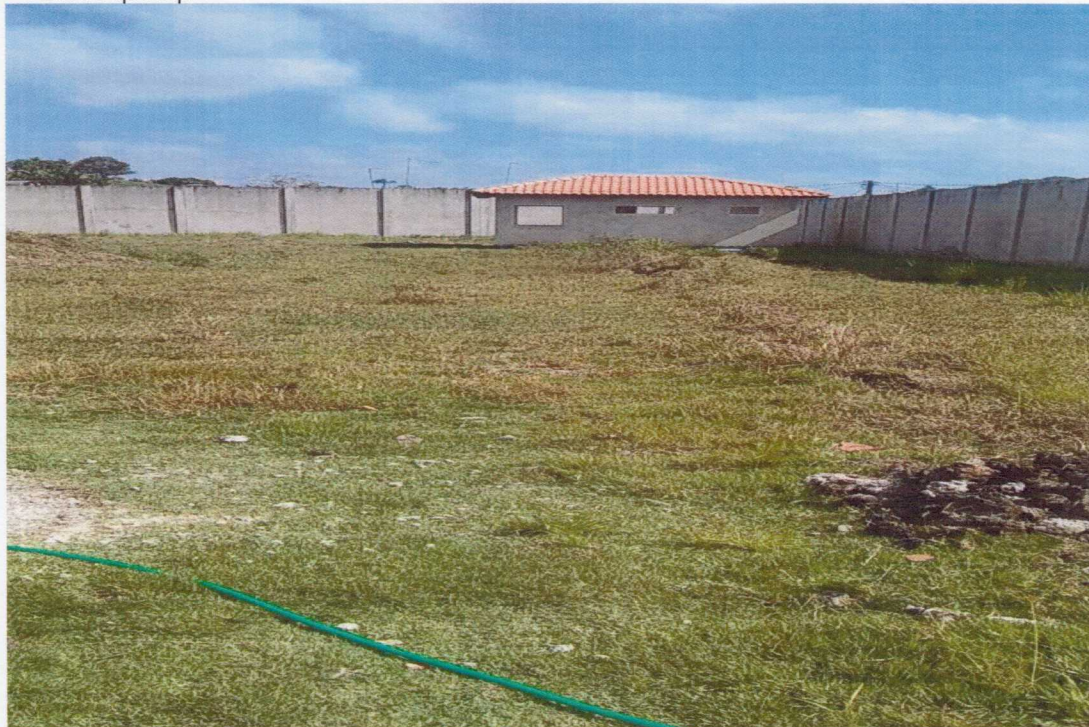
Foto 01 – Vista do quiosque
