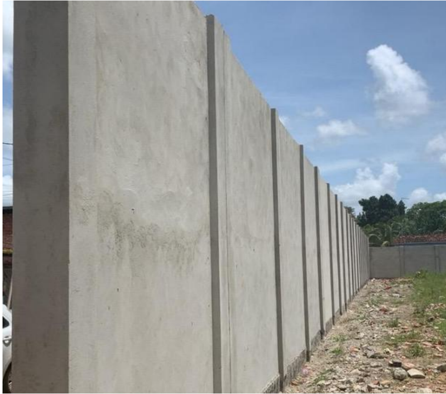
Foto 03 – Construção do muro.
