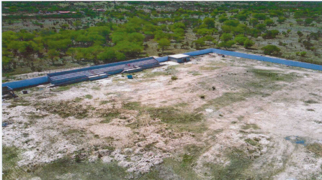
Foto 03 – Vista da arquibancada e do prédio do banheiro público.
