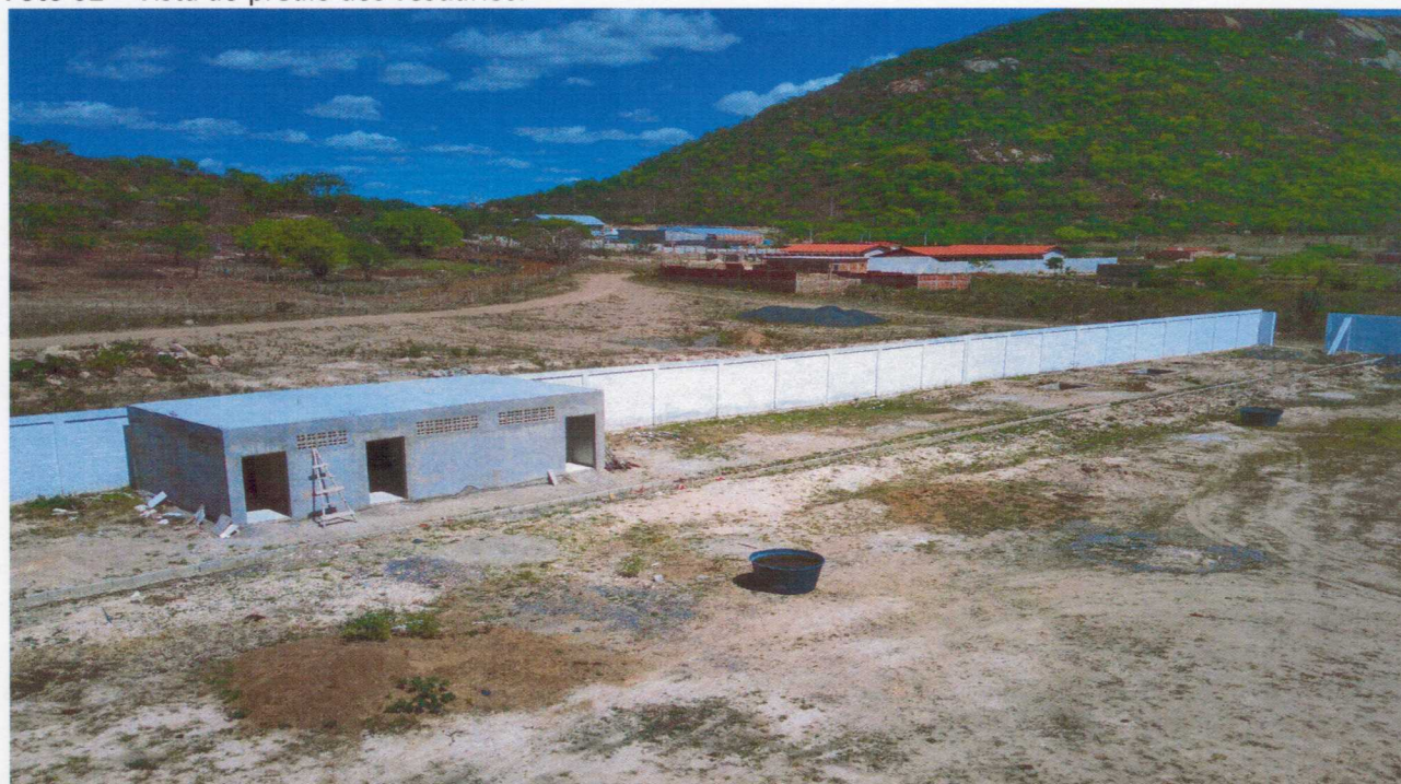
Foto 02 – Vista do prédio dos vestiários.
