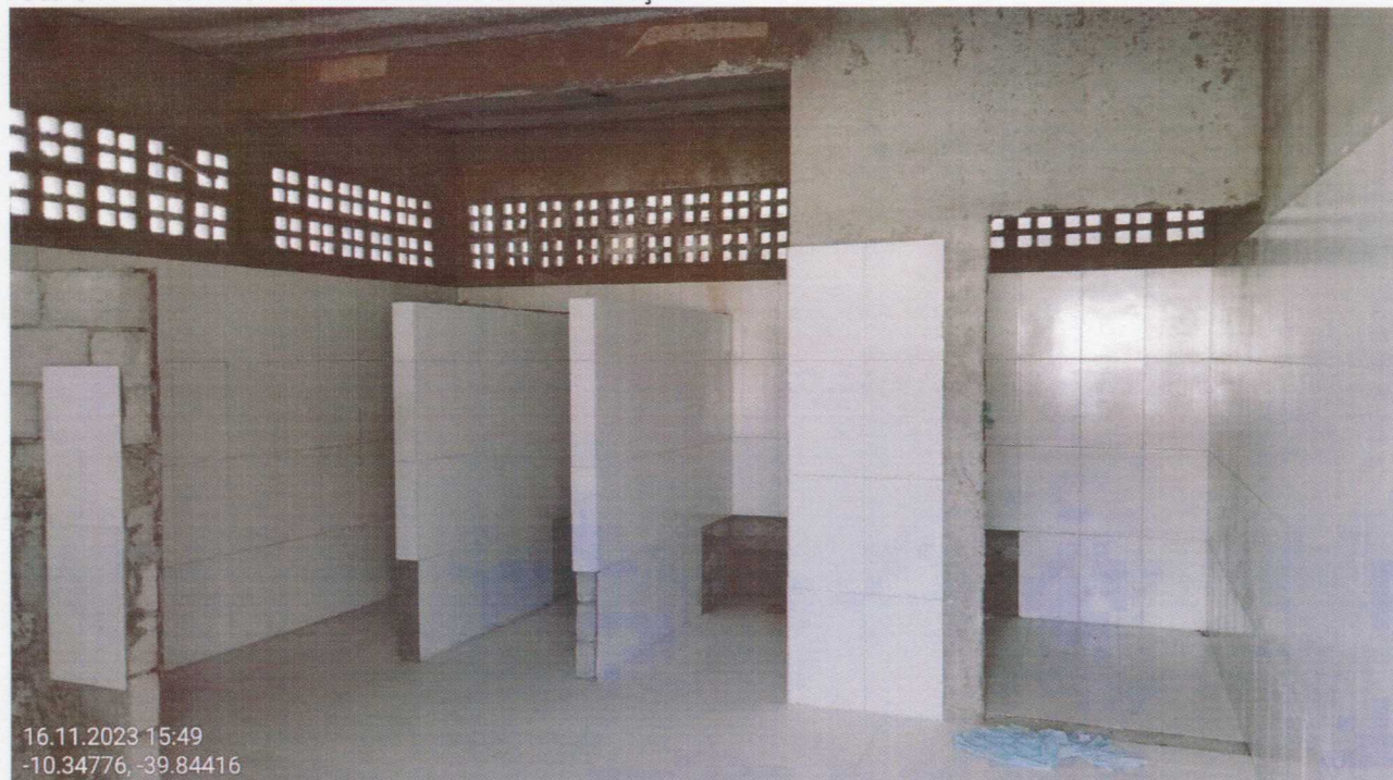
Foto 04 – Vista interna dos vestiários em Construção.
