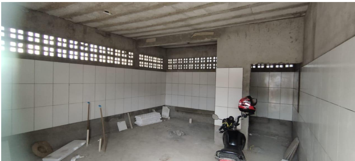
Foto 02 – Vista interna dos Vestiários.
