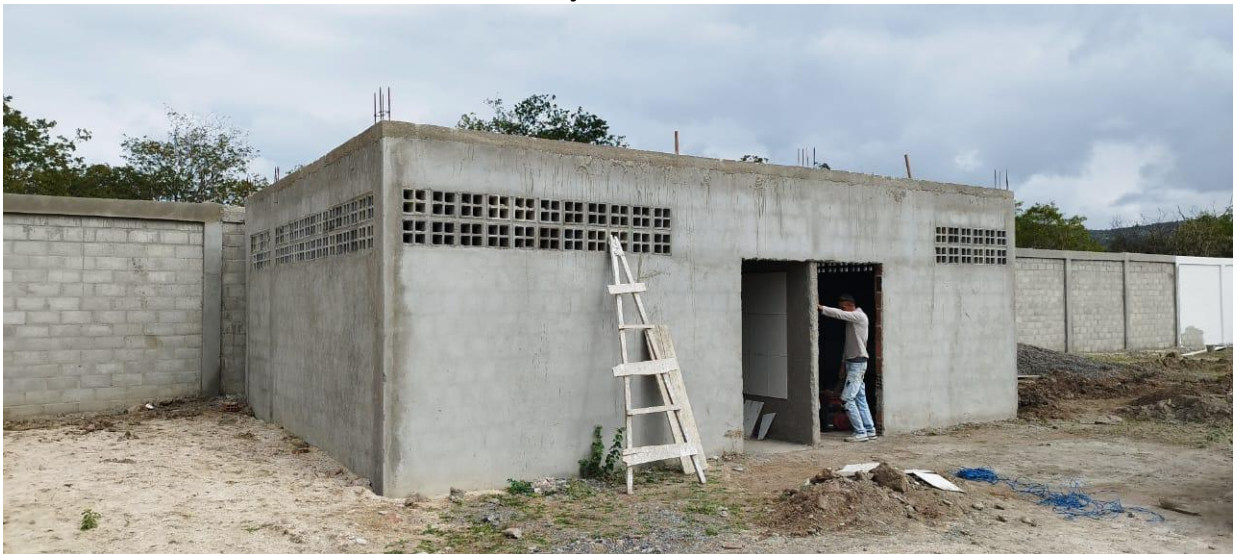
Foto 04 – Vista do Sanitário Público em Construção.
