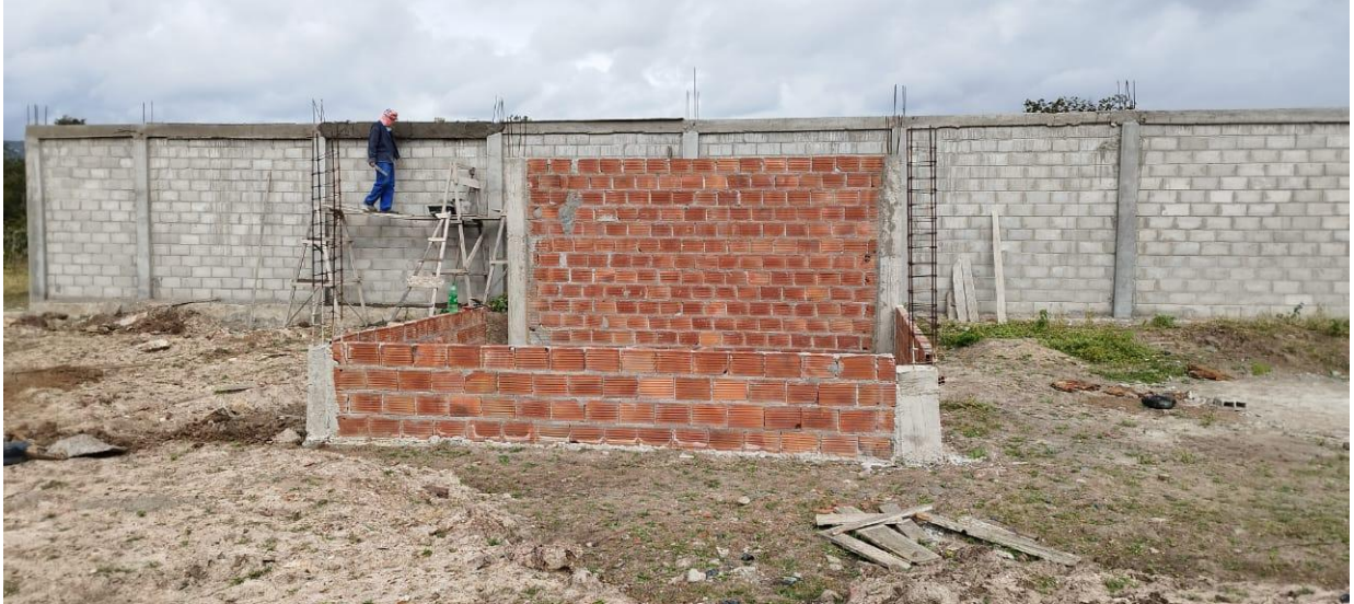
Foto 03 – Vista do quiosque em construção.
