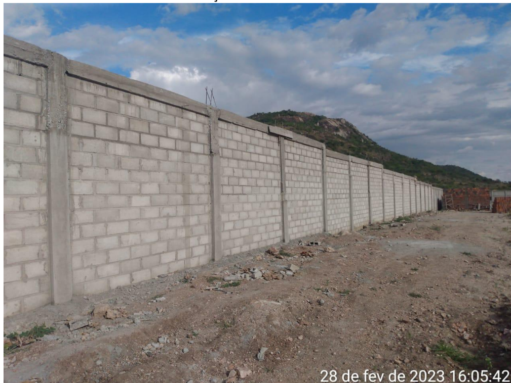
Foto 02 – Vista detalhe do muro em construção.
