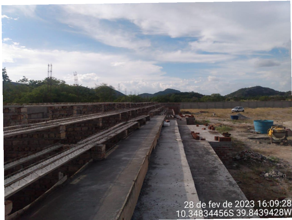
Foto 01 – Vista da construção da Arquibancada.
