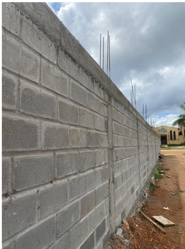
Foto 04 – Alvenaria da construção do muro no entorno.
