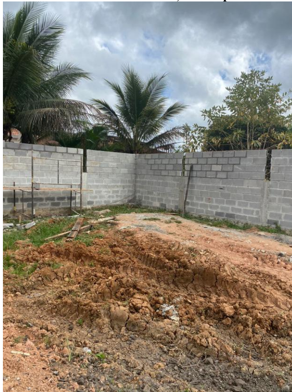
Foto 04 – Alvenaria da construção do muro no entorno.
