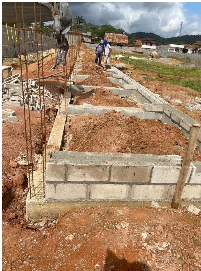
Foto 03 – Alvenaria da construção do muro no entorno.
