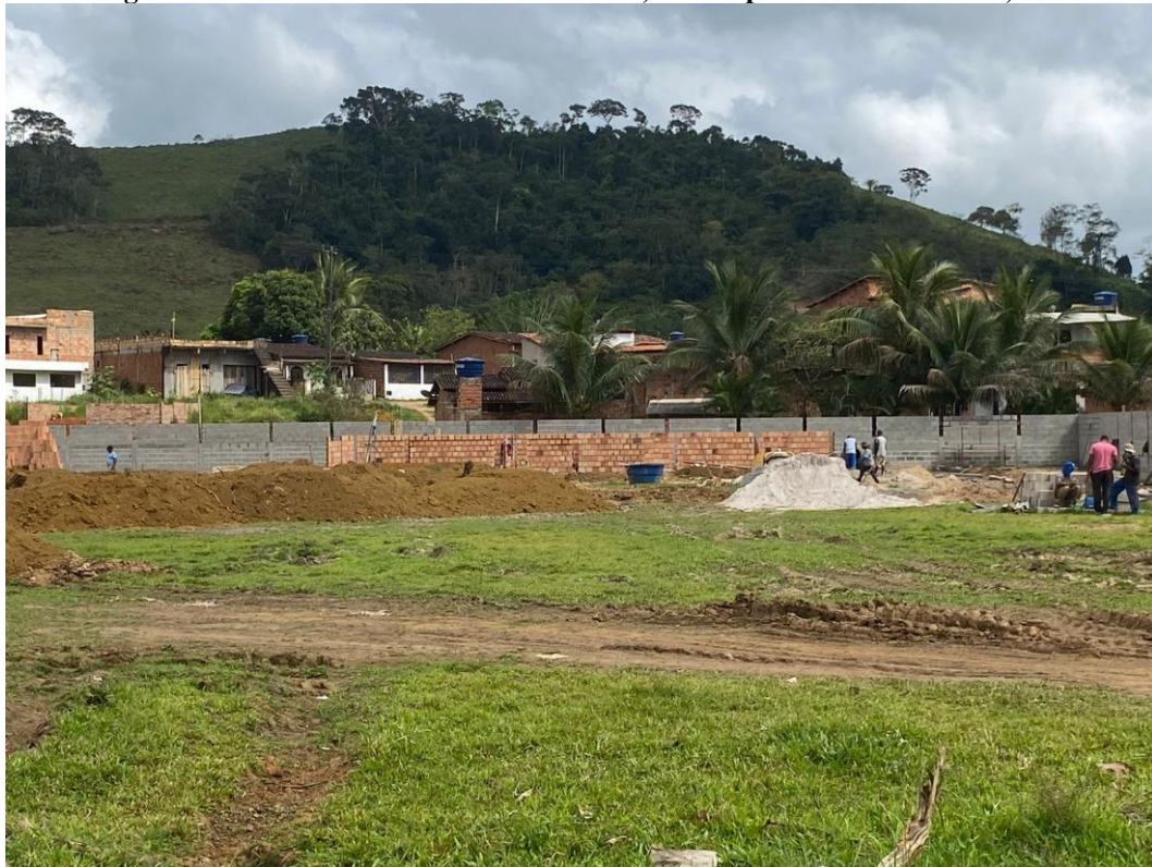
Foto 02 – Fundação da arquibancada.
