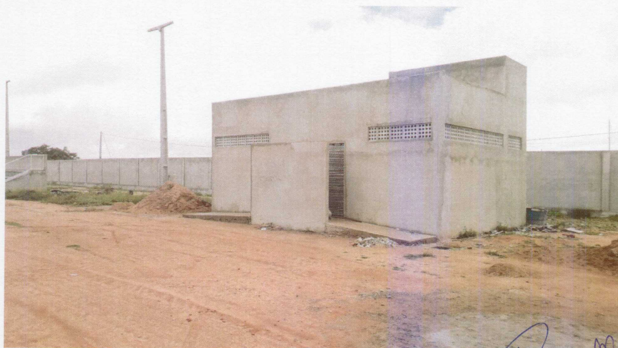
Foto 04 – Vista externa do Sanitário Público.
