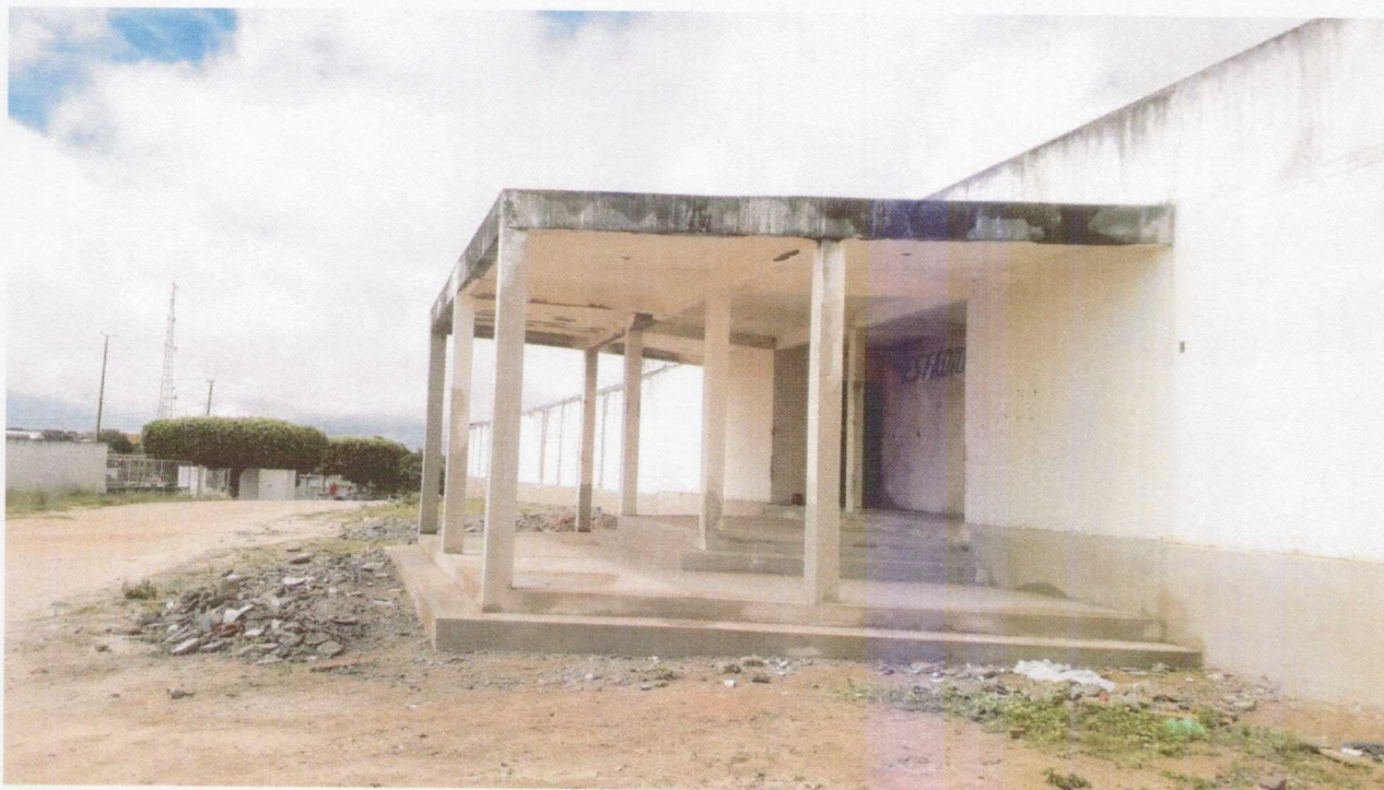
Foto 01 – Vista da atual entrada do Estádio – Recuperação de reboco e piso cimentado.
