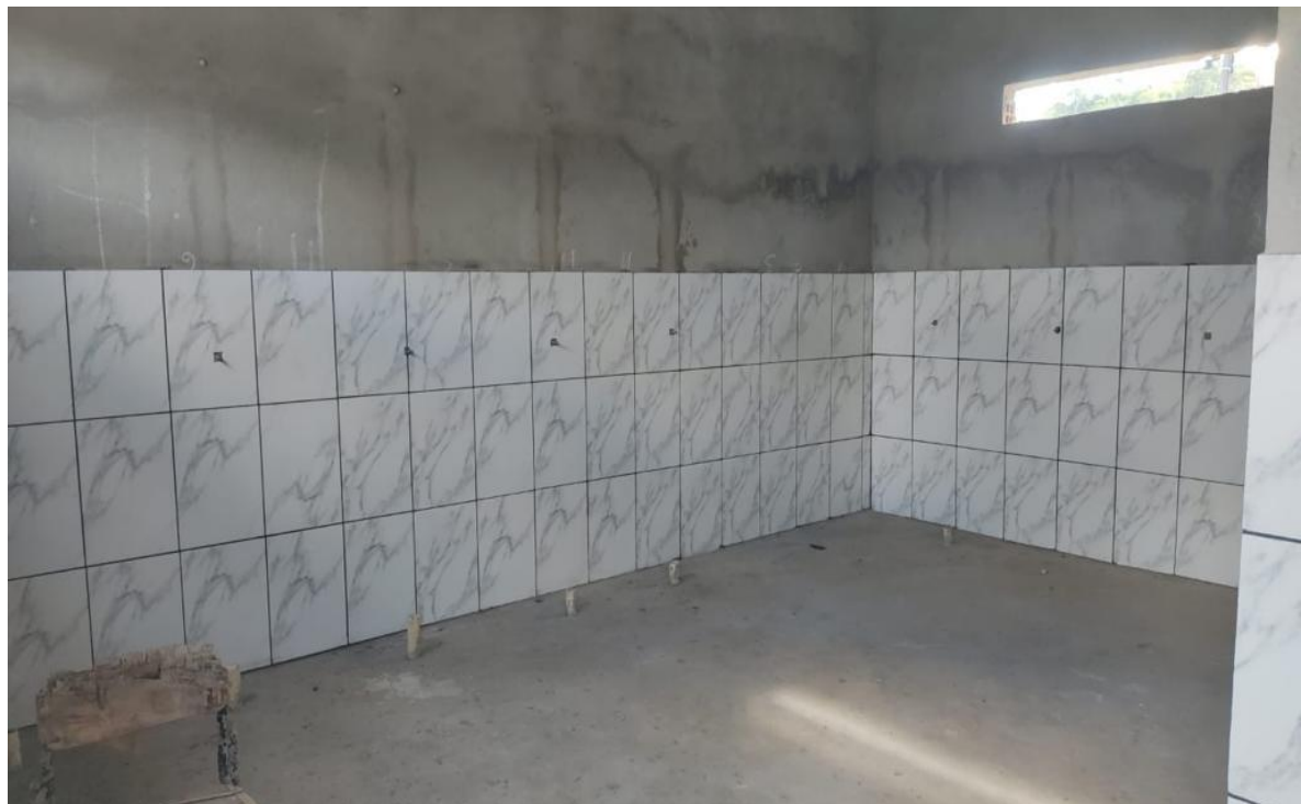
Foto 04 – vestiário área interna.
