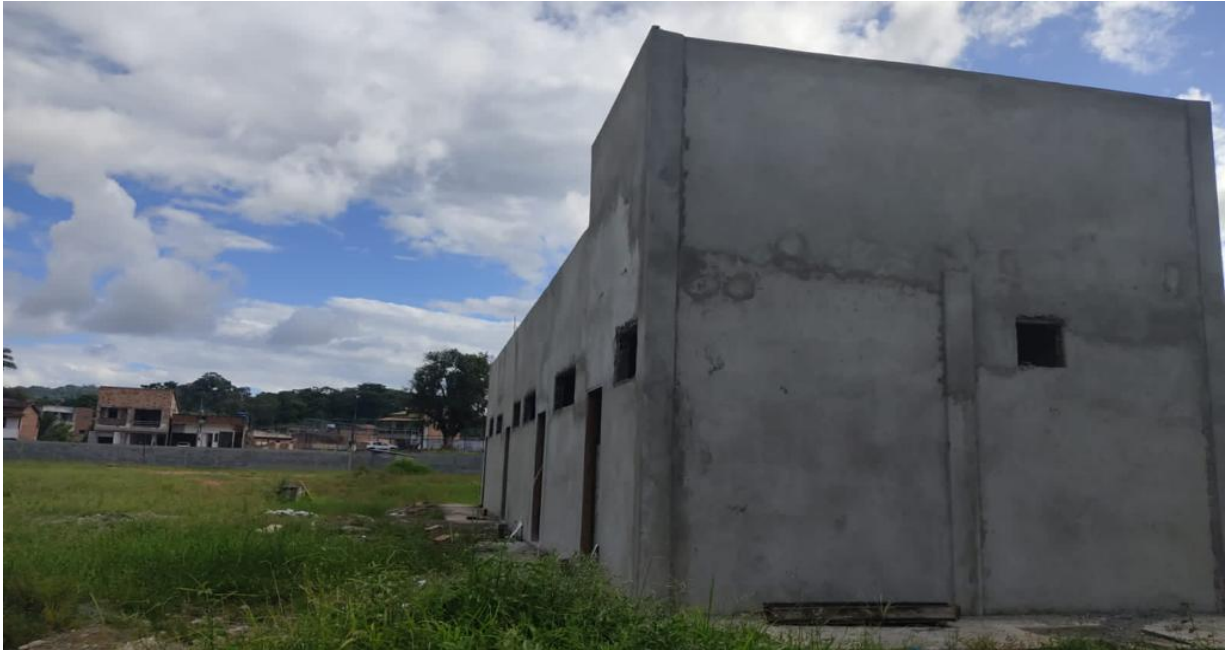
Foto 03 – Construção do vestiário, área externa.
