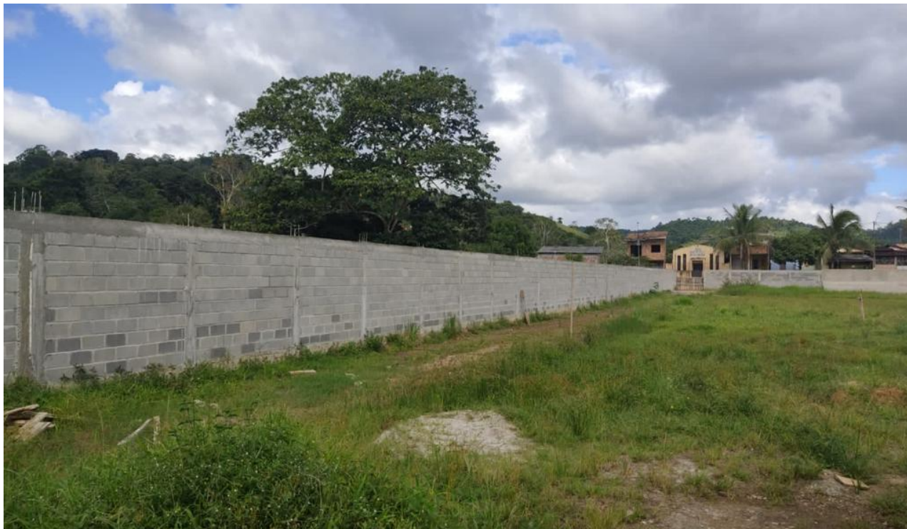
Foto 01 – construção do muro.
