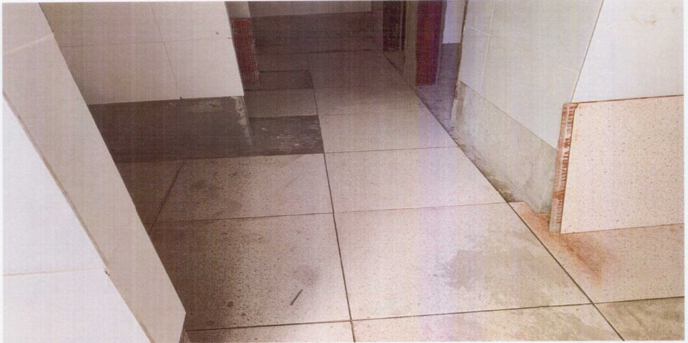
Foto 01 – Execução do Sanitário público, área interna.
