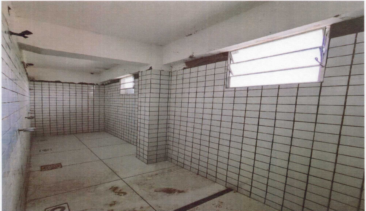
Foto 02 – Vista do vestiário
