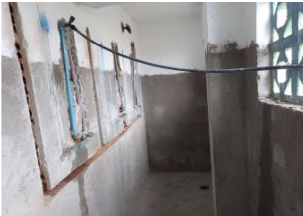
Foto 02 – Reforma das instalações hidrossanitárias.
