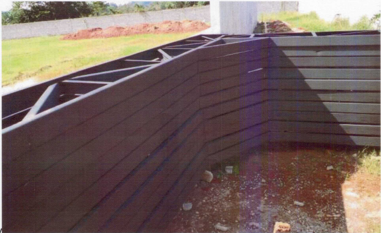
Foto 04 – VISTA DA FERRAGEM DA COBERTURA DA ARQUIBANCADA
