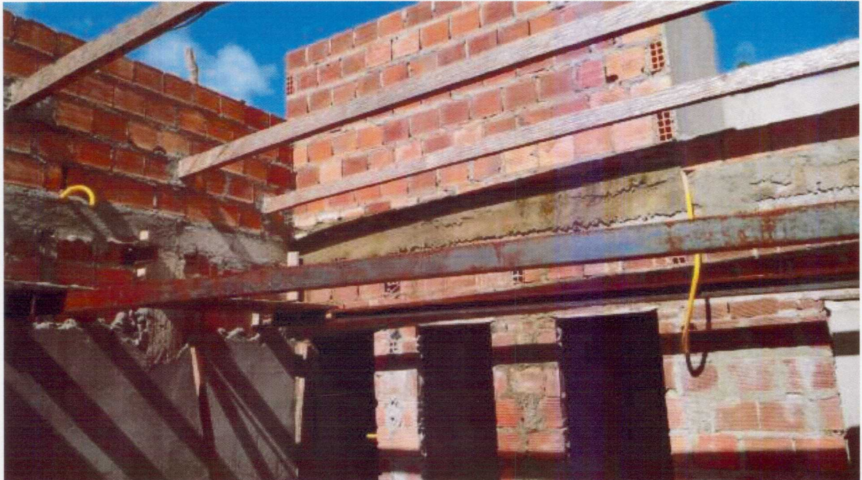
Foto 03 – VISTA DA COBERTURA DO SANITÁRIO EM ANDAMENTO
