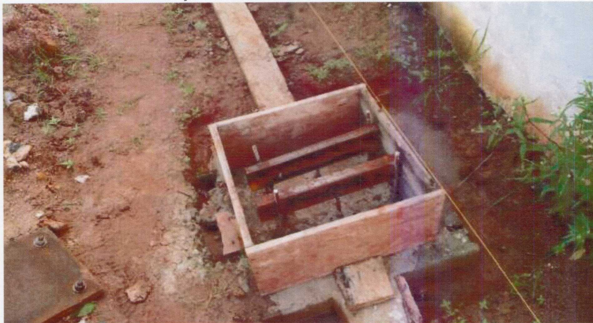
Foto 05 – VISTA DA FUNDAÇÃO DA COBERTURA DA ARQUIBANCADA
