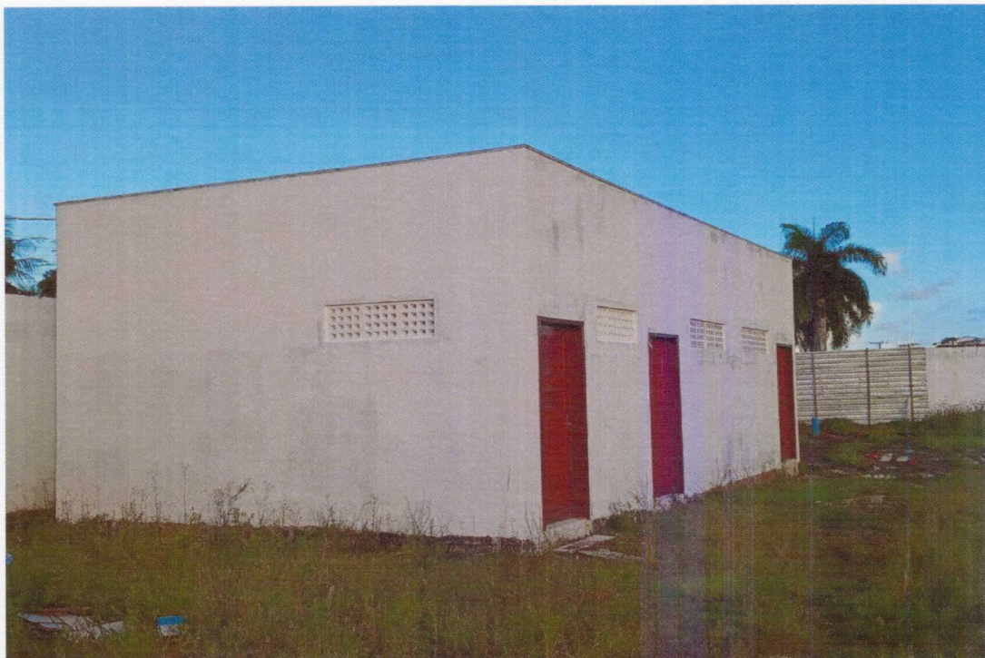
Foto 01 —Vista do vestiário.
