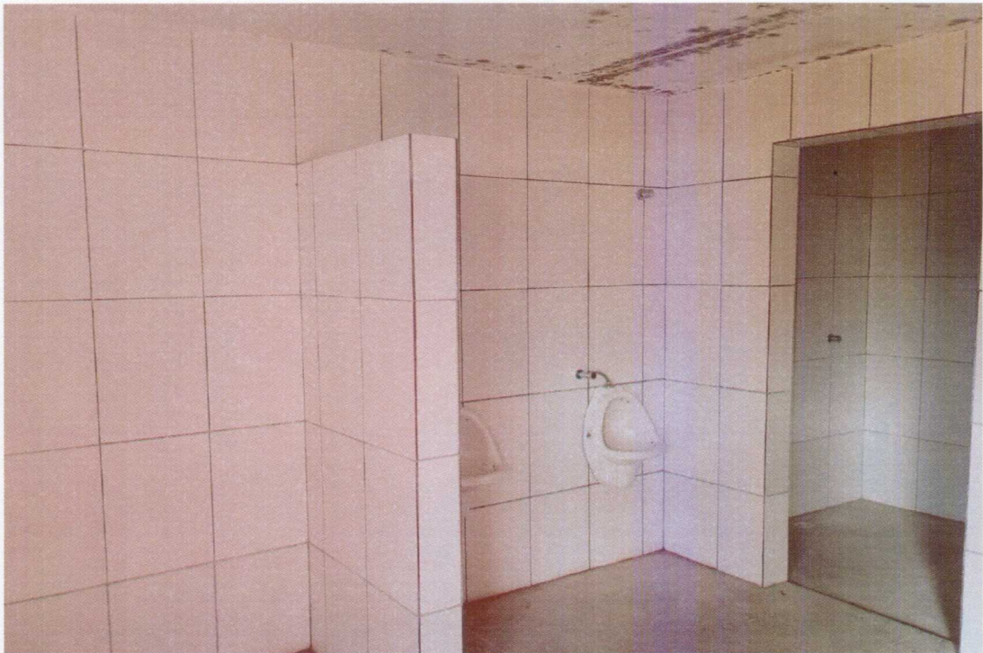
Foto 03—Vista interna do vestiário.
