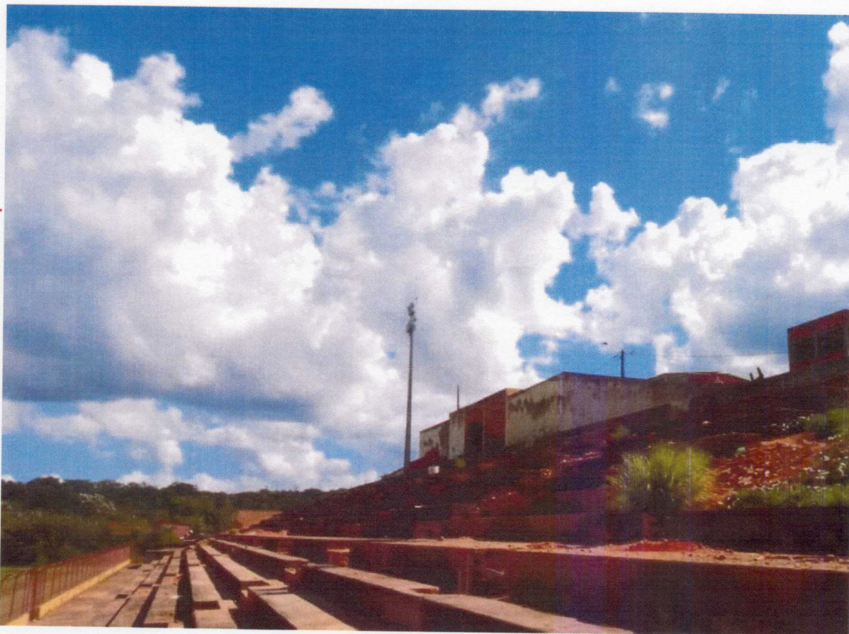
FOTO 03 – Visão geral da arquibancada existente
