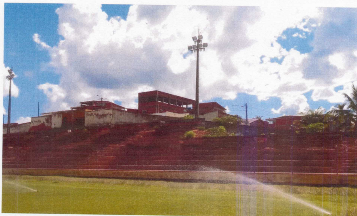
FOTO 04 – Vista frontal do campo p/ arquibancada
