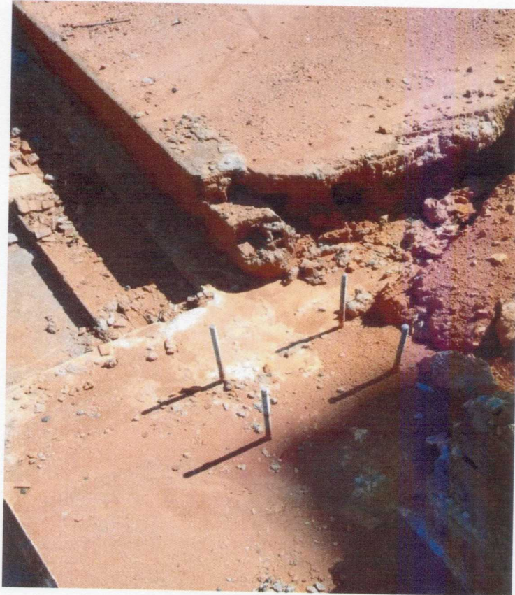
FOTO 01 – Arranque de um dos pilares
