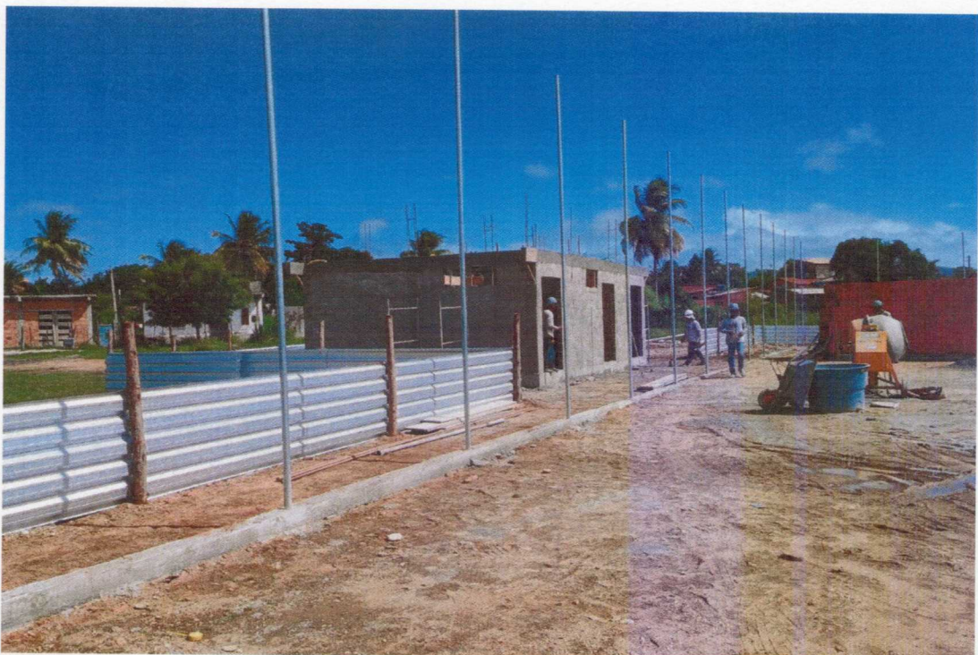
Foto 02 - Vista da construção do vestiário
