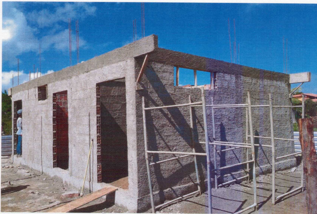
Foto 05—Vista construção do vestiário
