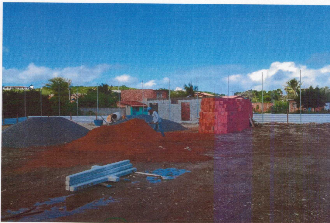
Foto 04—Vista construção da areninha
