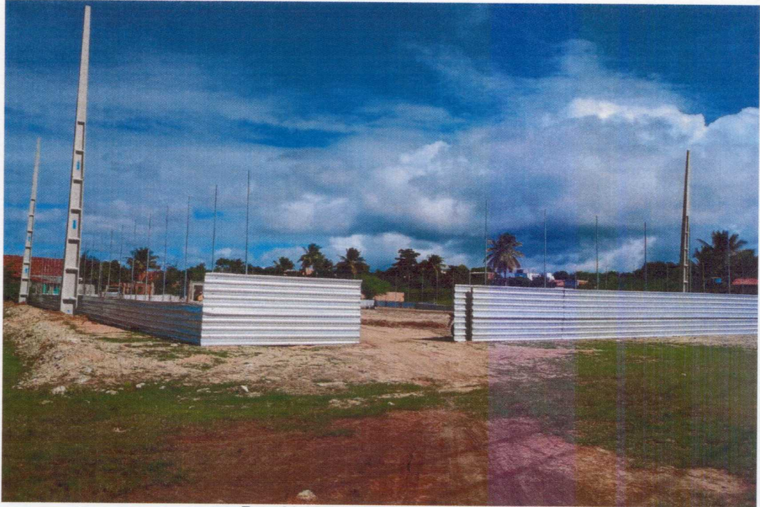
Foto 01 - Vista construção da areninha
