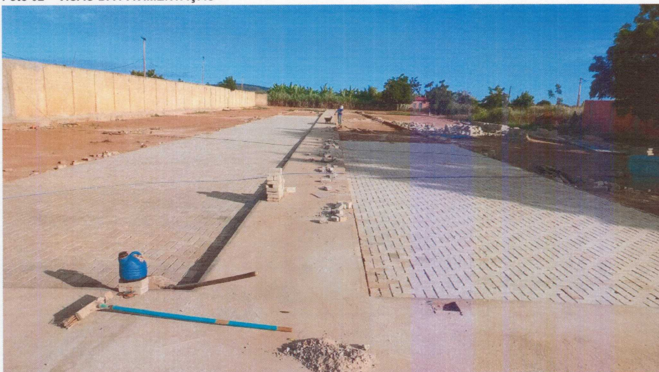
Foto 02 – VISÃO DA PAVIMENTAÇÃO
