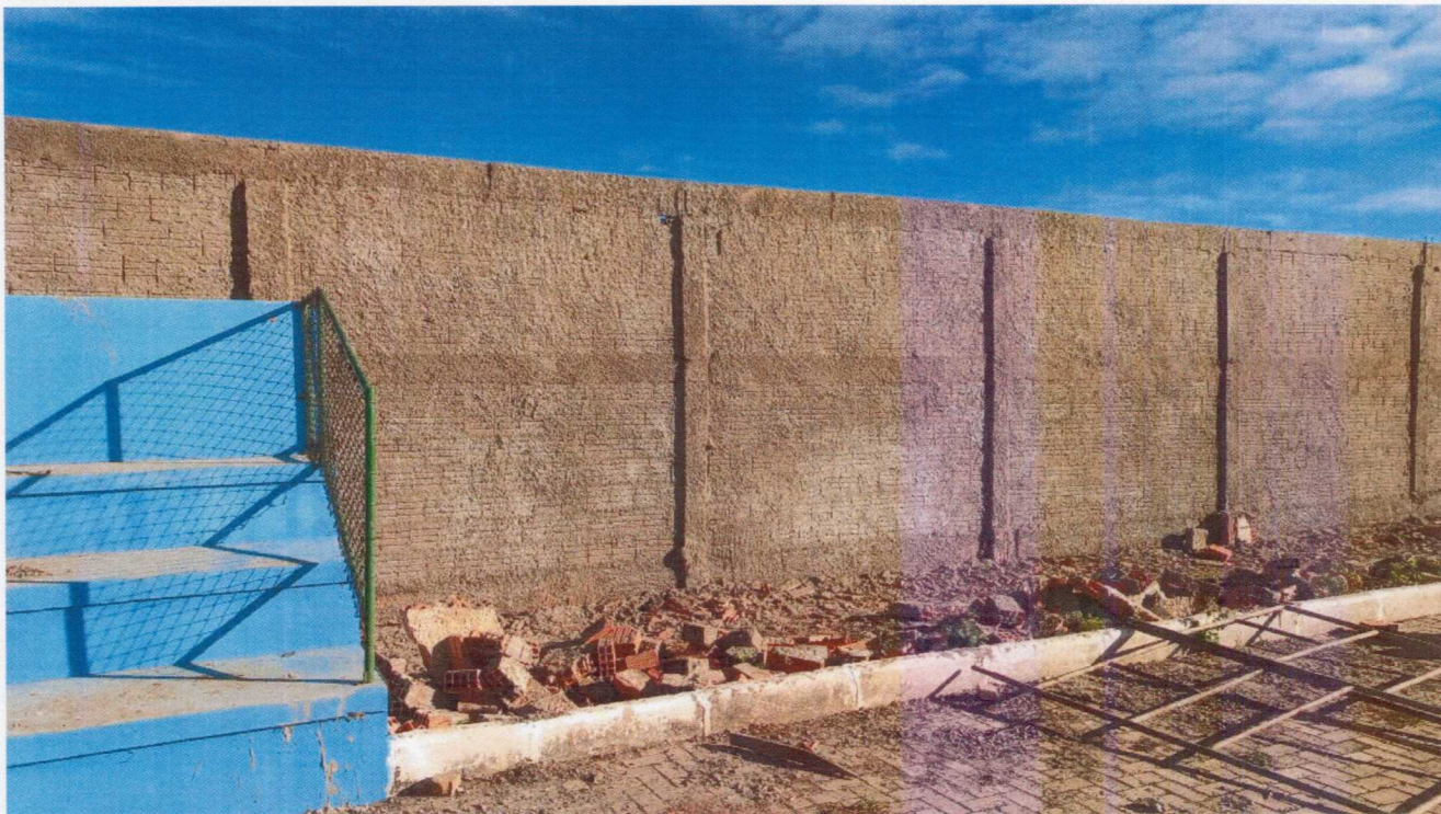
Foto 01 – VISÃO DO MURO RECUPERADO
