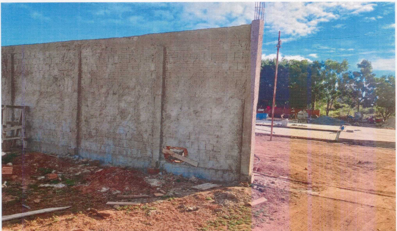
Foto 04 – VISÃO DO MURO
