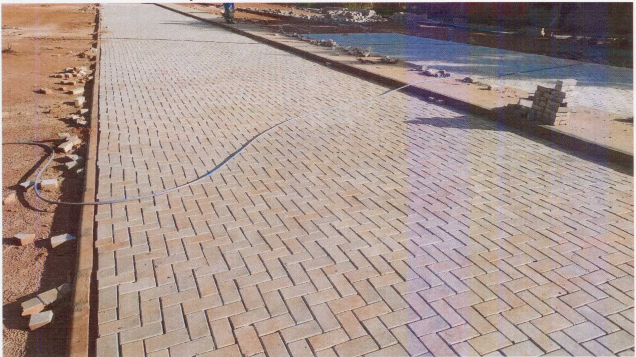
Foto 03 – VISÃO DA PAVIMENTAÇÃO
