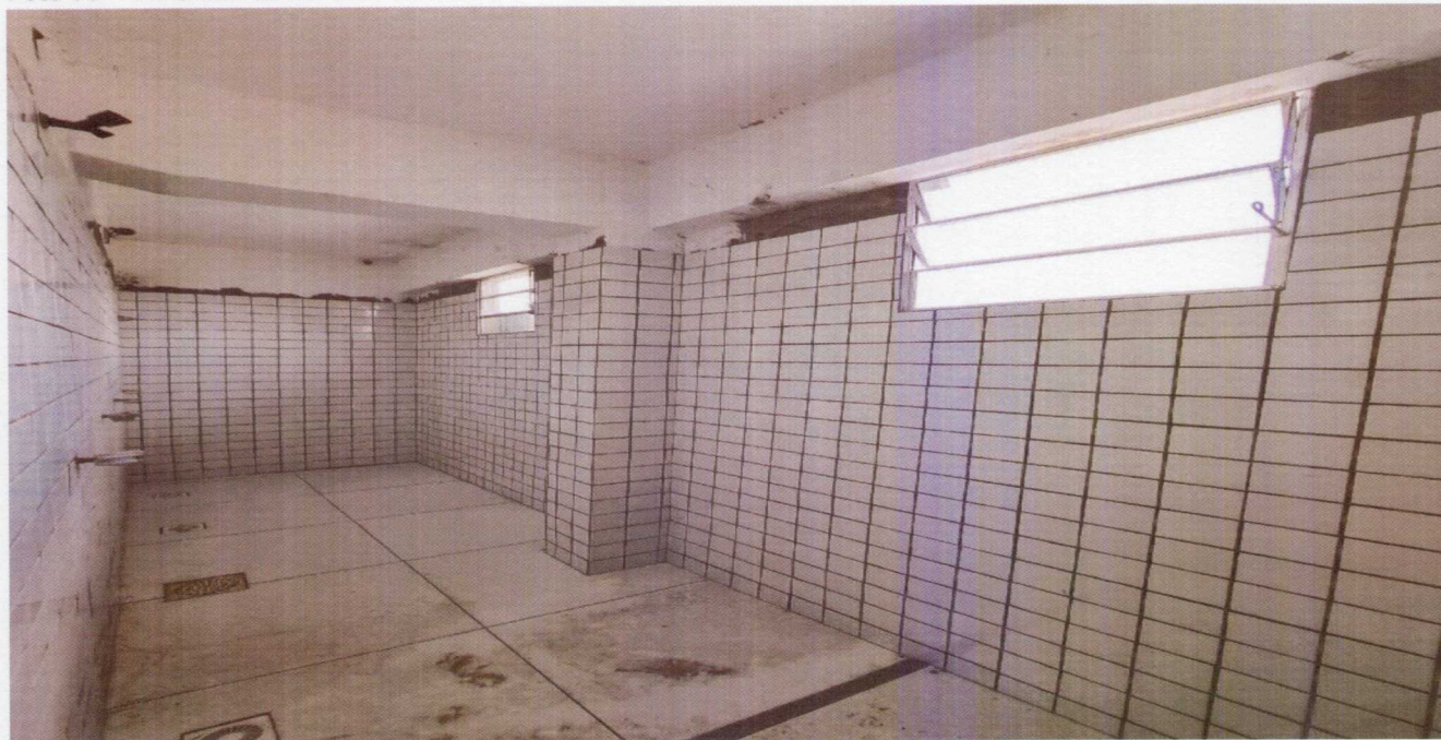
Foto 03 – Vista do vestiário
